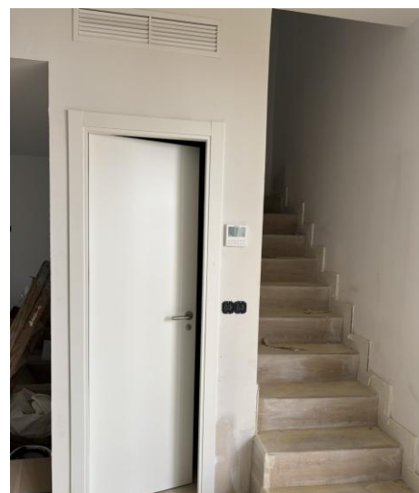
Fotografía 4. Vista puerta de aseo junto a escalera gres
