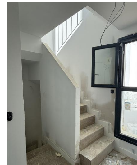
Fotografía 6. Vista escalera subida a castillete.
