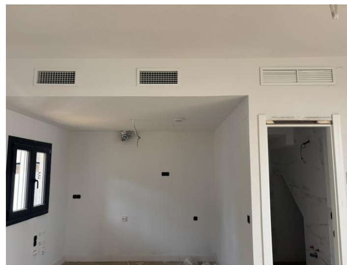
Fotografía 5. Vista interior de cocina vivienda c/ Las Melias.
