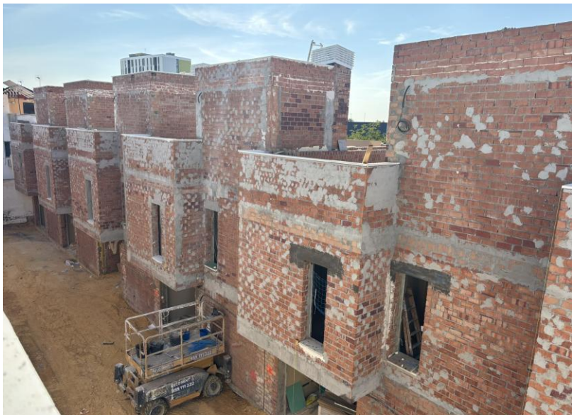
Fotografía 5. Preparación fachadas antes del enfoscado.
