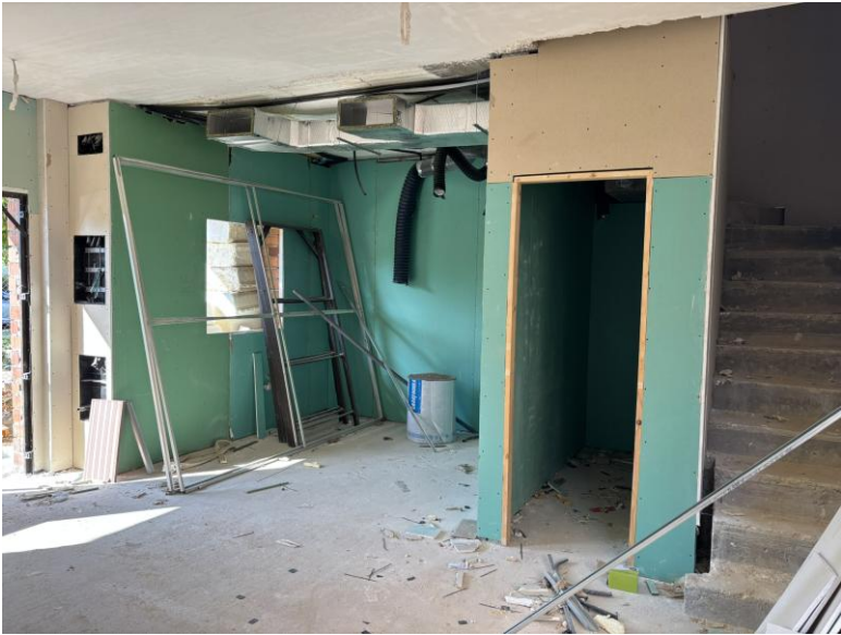
Fotografía 3. Vista cocina en c/ Las Melias
