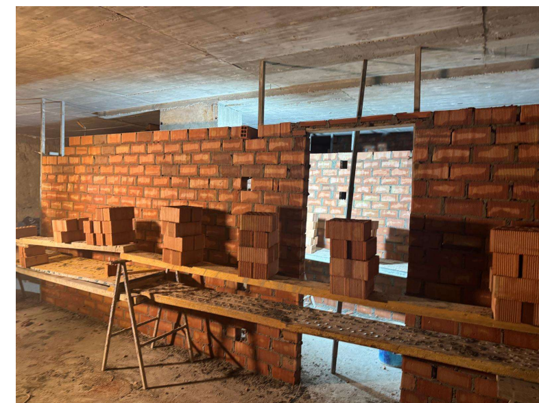
Fotografía 5. Trabajos de albañilería en plantas sótano
