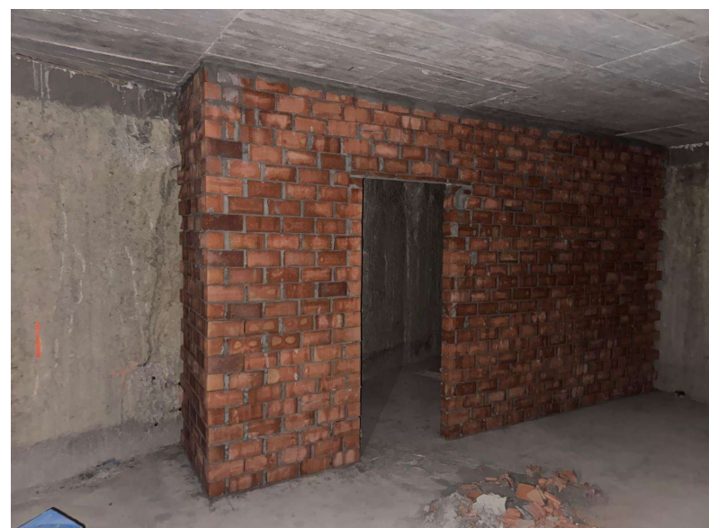
Fotografía 5. Trabajos de albañilería en plantas sótano
