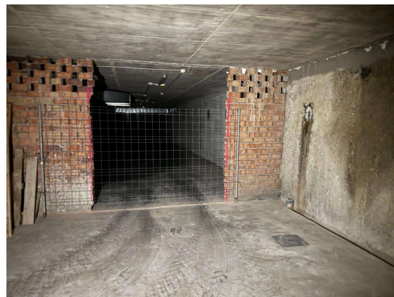
Fotografía 4. Apertura de hueco 2ª fase para acceso material
