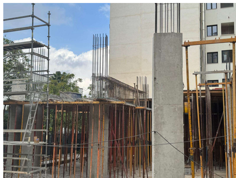
Fotografía 1. Pilares planta baja
