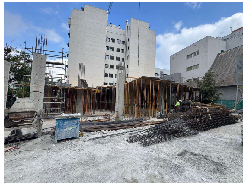
Fotografía 2. Encofrado para forjado cubre-baja
