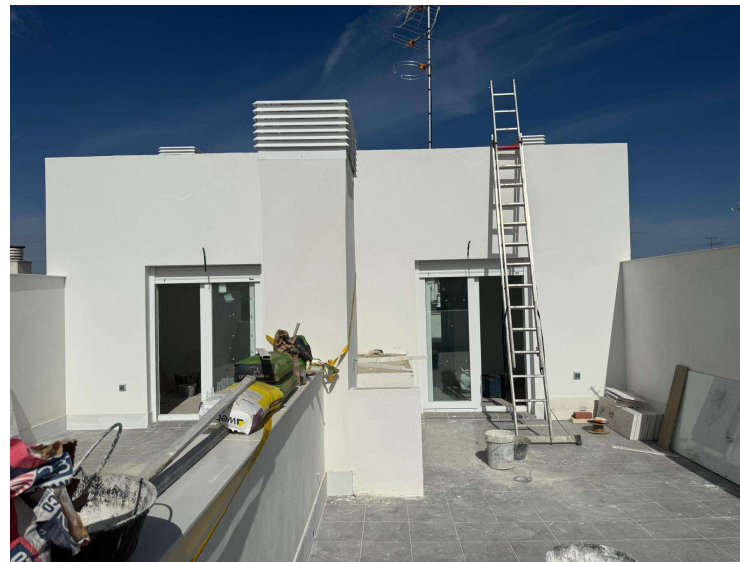
Fotografía 2. Fachada trasera planta ático
