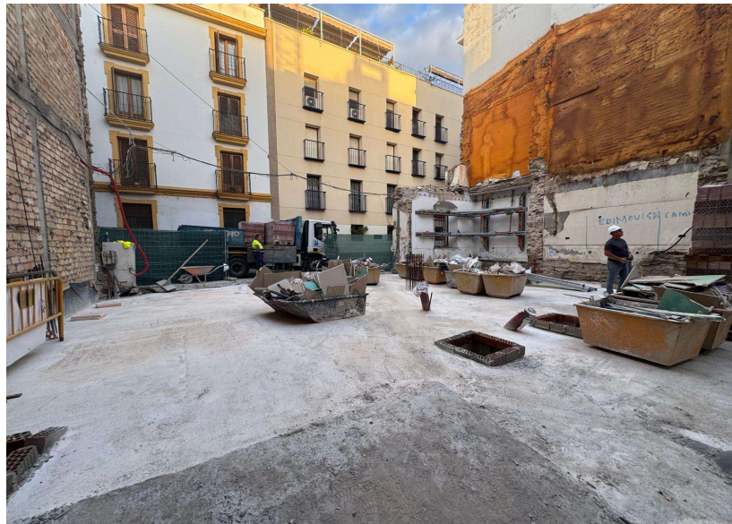
Fotografía 1. Cimentación zona edificio delantero
