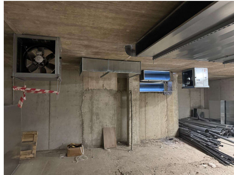
Fotografía 2. Trabajos en planta sótano. Inst ventilación
