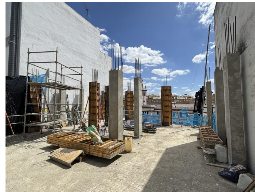
Fotografía 4. Desencofrado pilares P.tercera-cuarta
