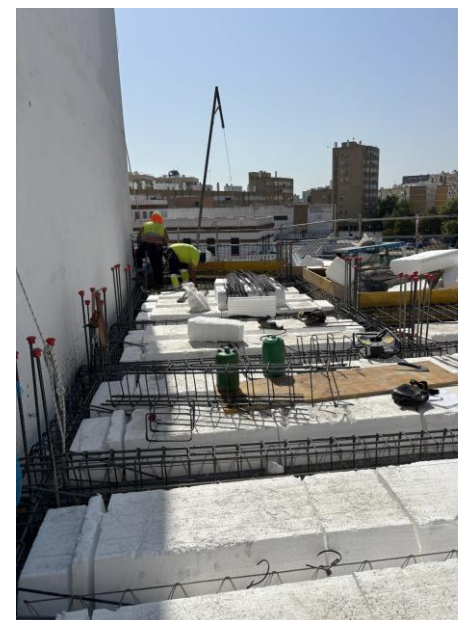
Fotografía 2. Preparación forjado P tercera.
