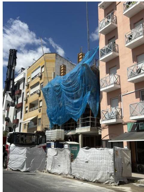
Fotografía 1. Ejecución forjado P. tercera
