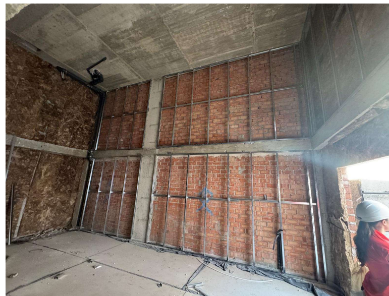
Fotografía 5. Continúan trabajos interiores viviendas taller
