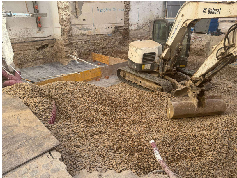
Fotografía 4. Inicio trabajos cimentación bloque de fachada
