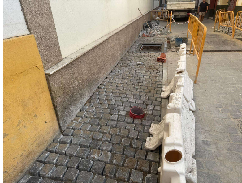
Fotografía 2. Reposición adoquinado zona acometida
