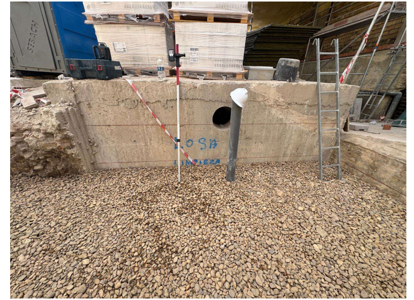
Fotografía 3. Inicio trabajos cimentación bloque de fachada
