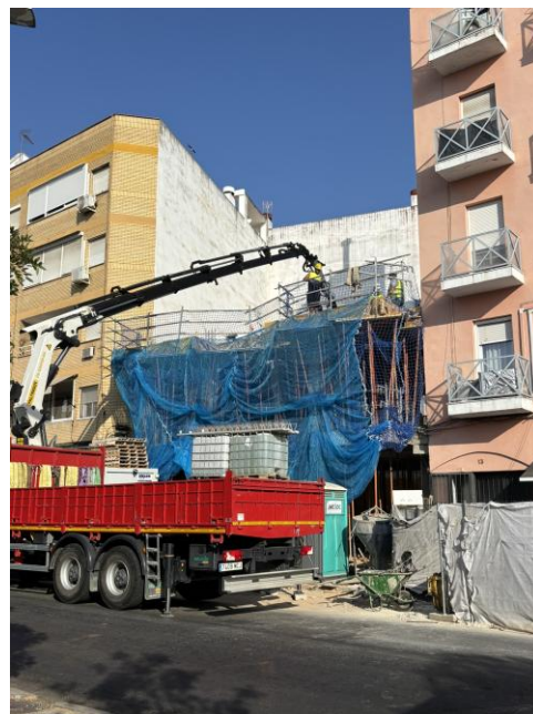
Fotografía 1. Ejecución forjado P. segunda
