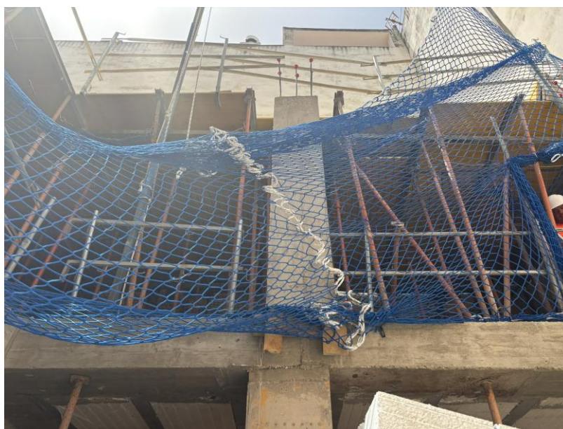
Fotografía 3. Vista desde patio P. segunda
