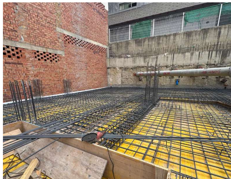
Fotografía 2. Encofrado y armadura forjado sótano -1
