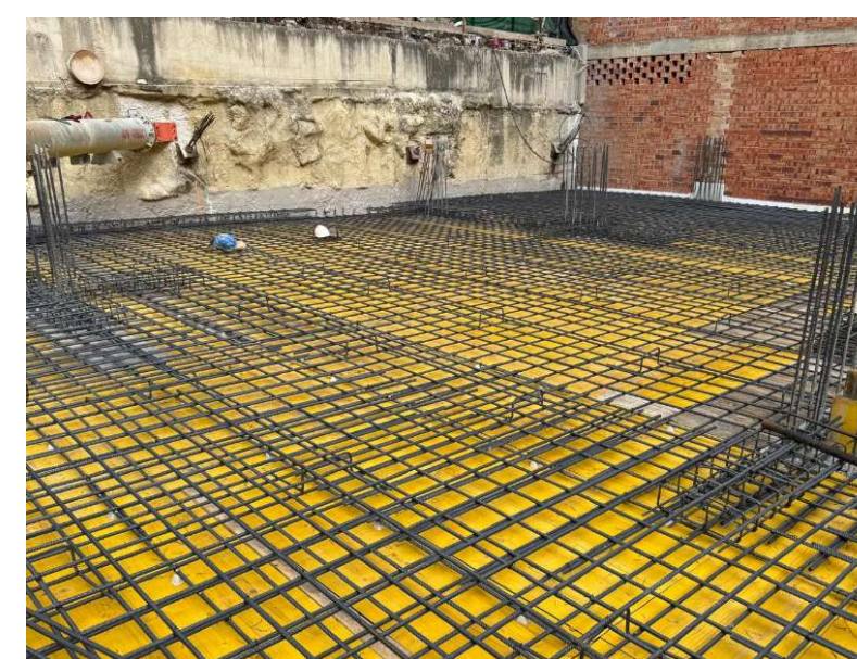
Fotografía 3. Encofrado y armadura forjado sótano -1
