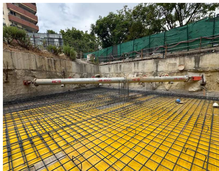
Fotografía 1. Encofrado y armadura forjado sótano -1
