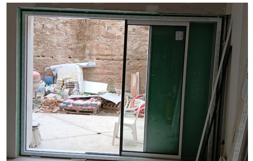
Fotografía 6. Instalación de ventanal corredero a fachada trasera
