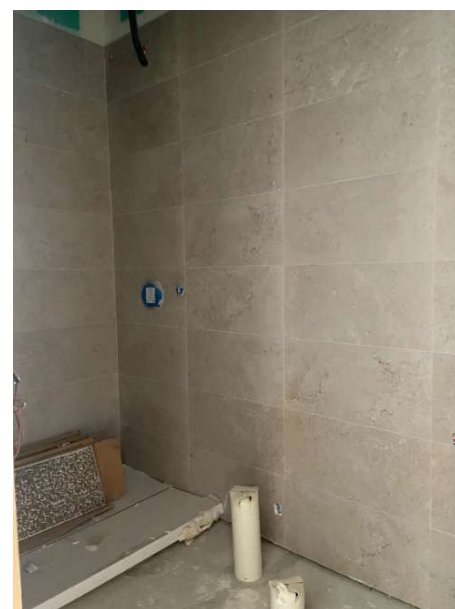
Fotografía 5. Alicatado baño completo (Personalización)
