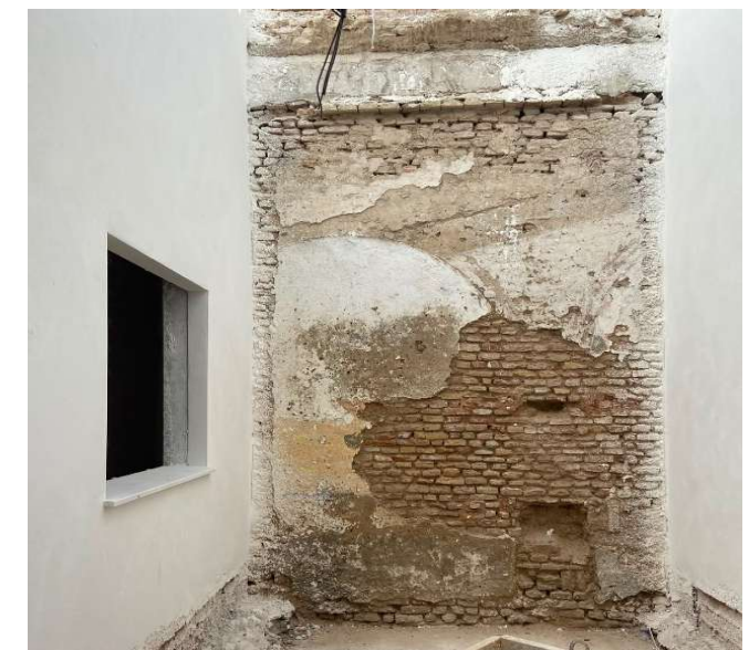
Fotografía 6. Vista de patio interior de una vivienda taller
