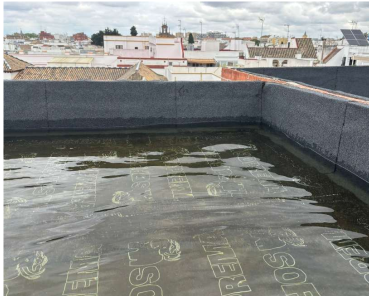
Fotografía 1. Prueba estanqueidad cubiertas
