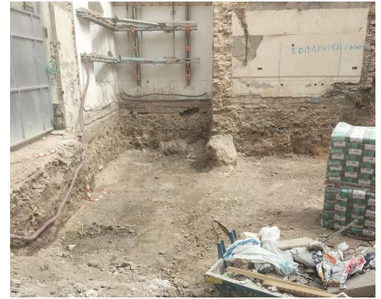
Fotografía 3. Excavación en zona de primera crujía
