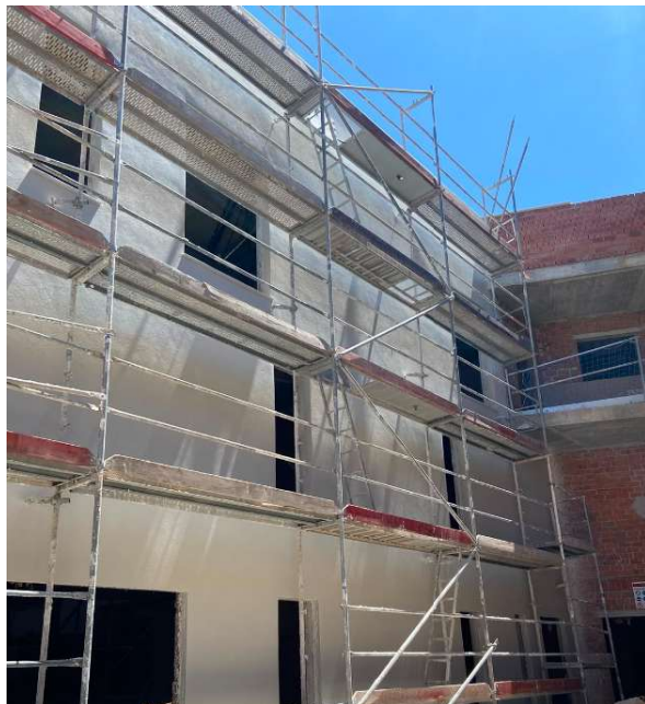
Fotografía 4. Enfoscado fachadas patios interiores
