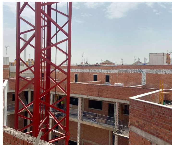
Fotografía 5. Vista general de cubiertas
