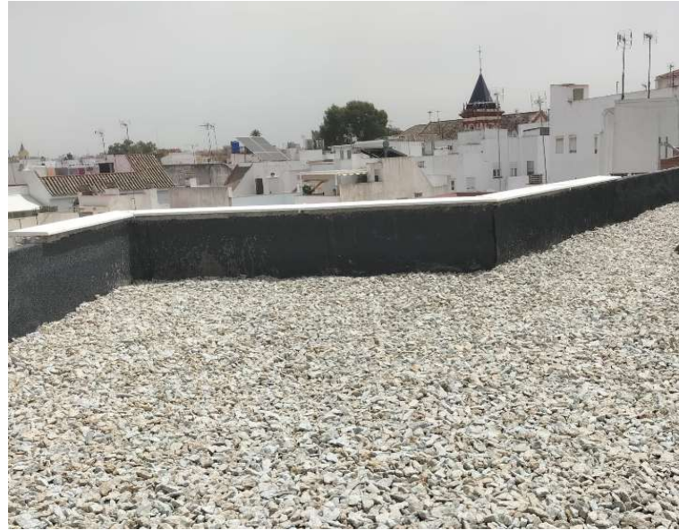
Fotografía 2. Cubiertas castillete grava terminadas.
