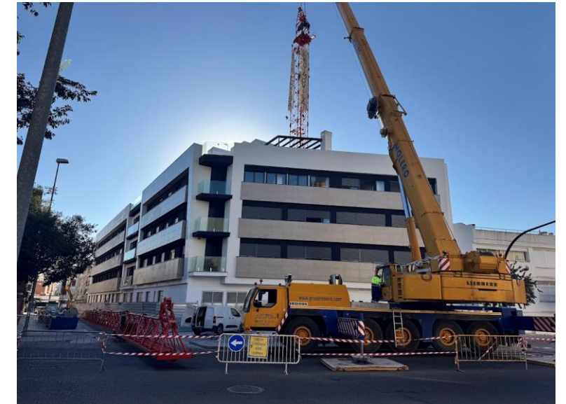
Fotografía 3. Desmontaje de Grúa Torre del bloque 1
