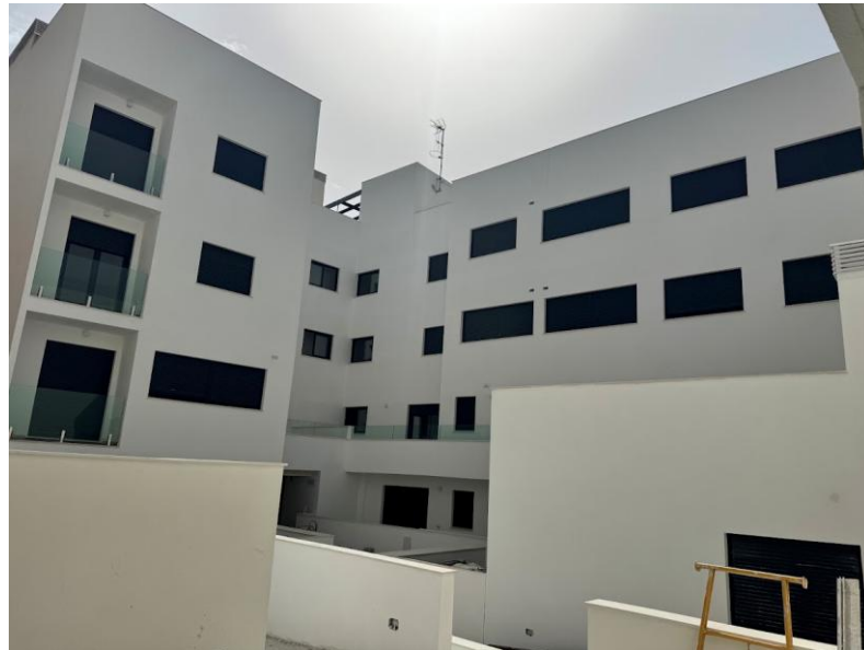
Fotografía 1. Perspectiva desde gimnasio hacia E4 en patio comunitario
