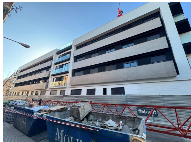
Fotografía 5. Fachada c/ Abderramán III finalizada sin andamios.
