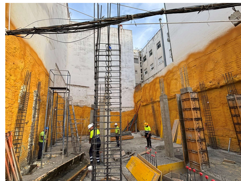
Fotografía 2. Armado pilares P.baja.
