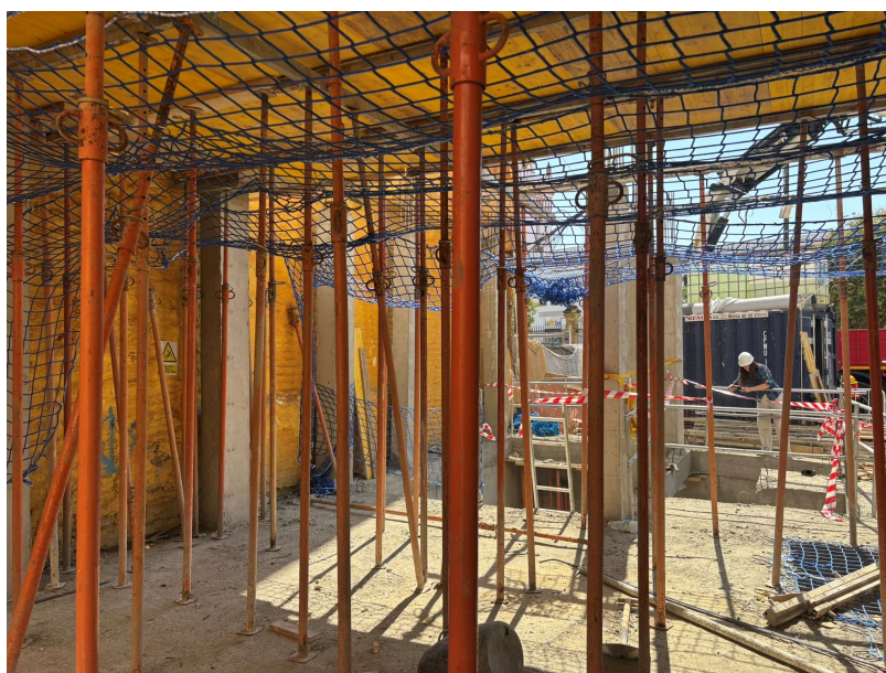
Fotografía 3. Montaje encofrado forjado P.1º
