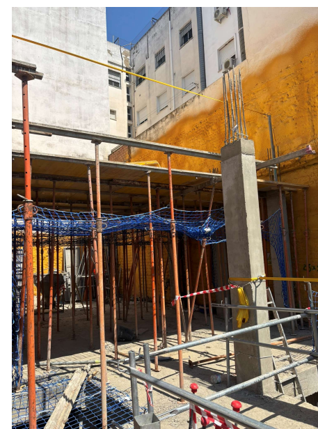
Fotografía 4. Montaje encofrado forjado P.1º
