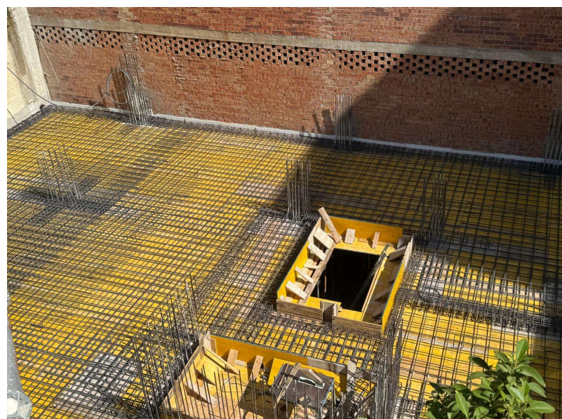
Fotografía 1. Encofrado forjado sótano -2
