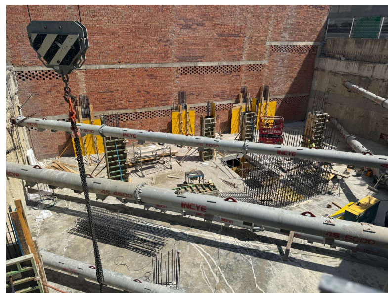
Fotografía 4. Forjado planta sótano -2
