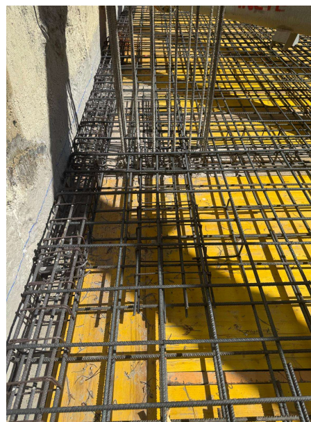
Fotografía 2. Revisión armado planta sótano -2
