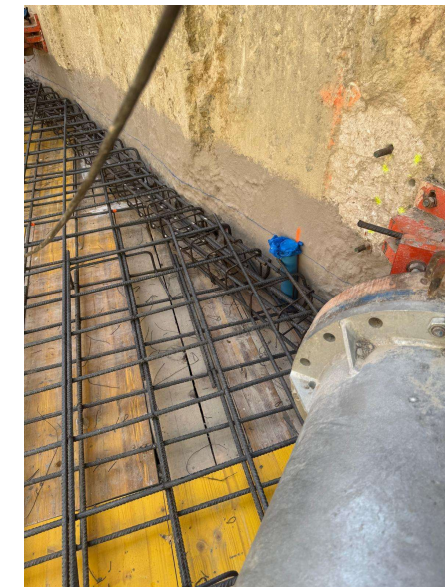
Fotografía 6. Impermeabilización cantos de forjado y prev. bajante
