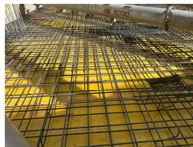
Fotografía 3. Revisión armado planta sótano -2
