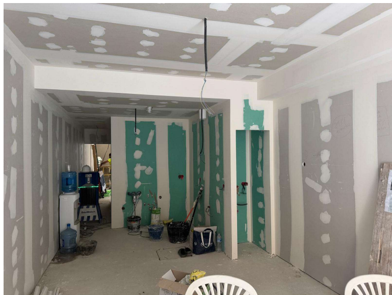
Fotografía 1. Trabajos de yeso laminado concluidos
