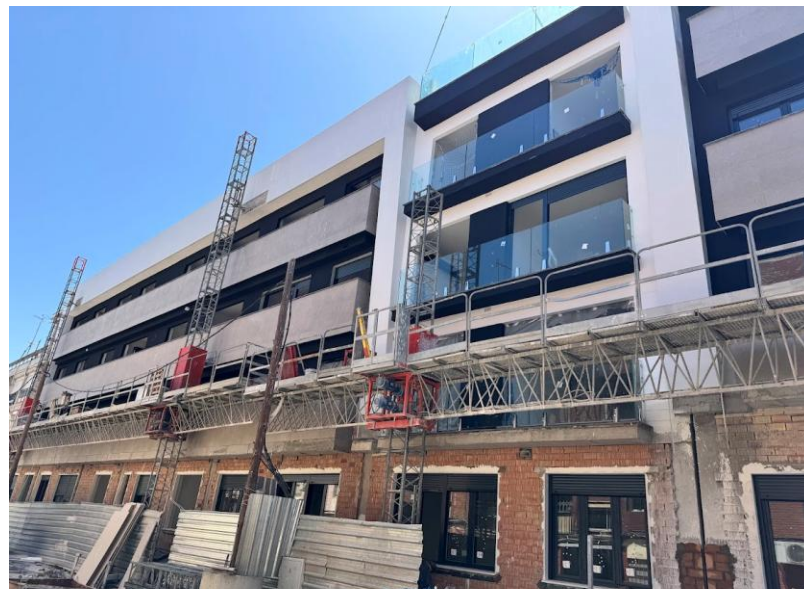
Fotografía 4. Estado actual fachada c/ Abderraman con la colocación de carpintería de aluminio
