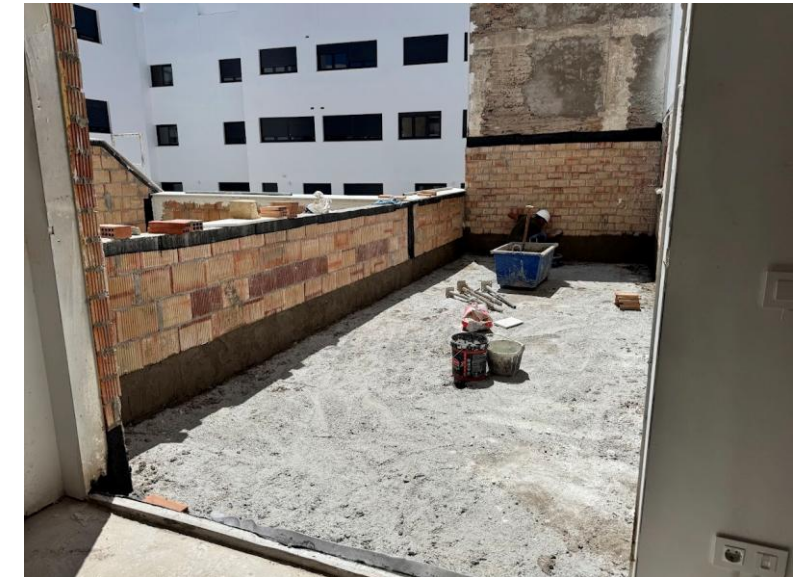
Fotografía 3. Ejecución cubiertas terrazas E3 planta 1
