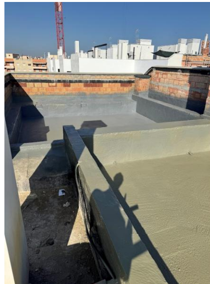
Fotografía 2. Piscina con protección de poliurea previo aplacado
