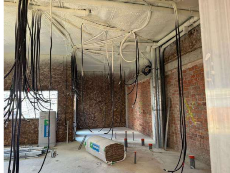
Fotografía 2. Trabajos de instalaciones
