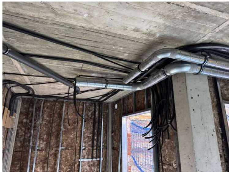
Fotografía 4. Trabajos de instalaciones
