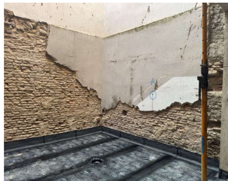
Fotografía 5. Trabajos de impermeabilización
