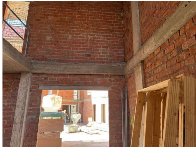
Fotografía 1. Trabajos de albañilería
