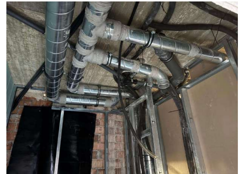
Fotografía 3. Trabajos de instalaciones
