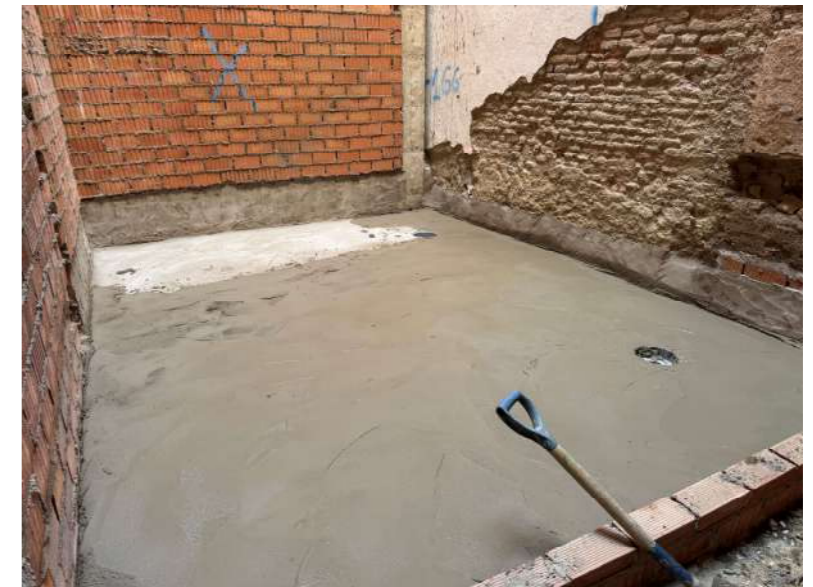
Fotografía 6. Trabajos de impermeabilización
