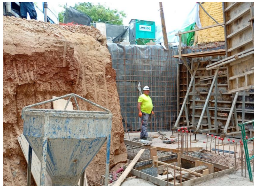
Fotografía 1. Zona foso ascensor
