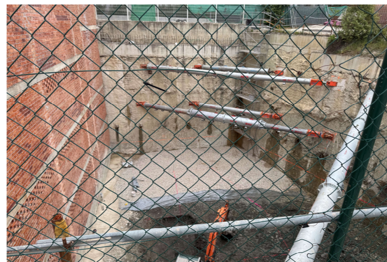
Fotografía 5. Replanteo de zonas comunes en sótano -3
