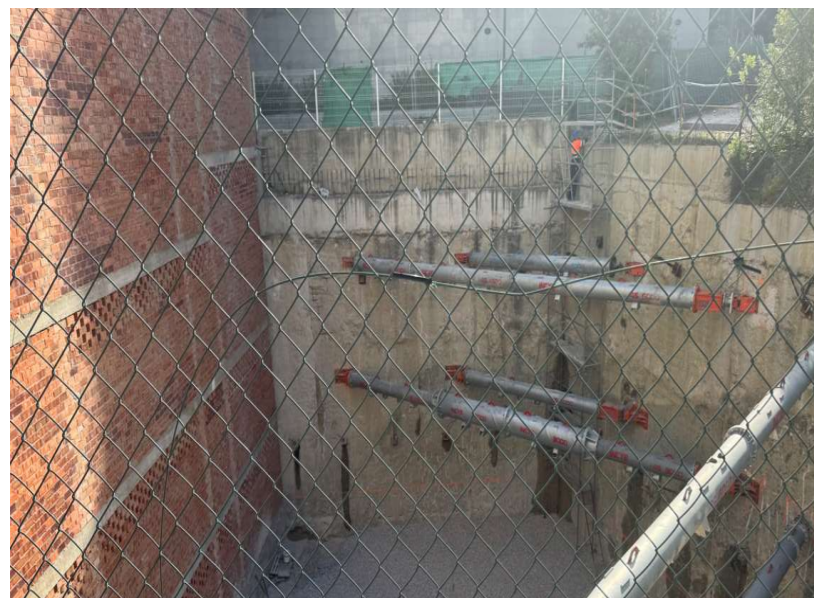
Fotografía 1. Acceso a obra con escalera de andamio
