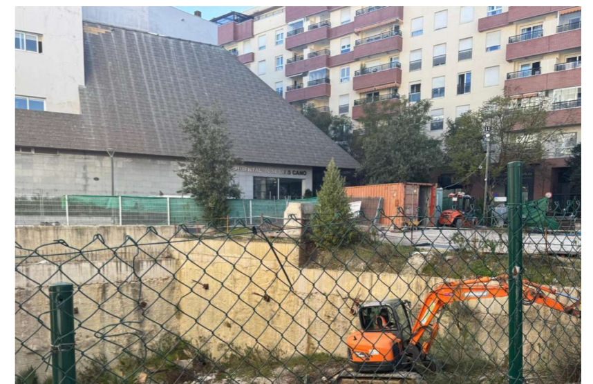
Fotografía 6. Estado previo de Plaza colindante. Casetas Obra.
