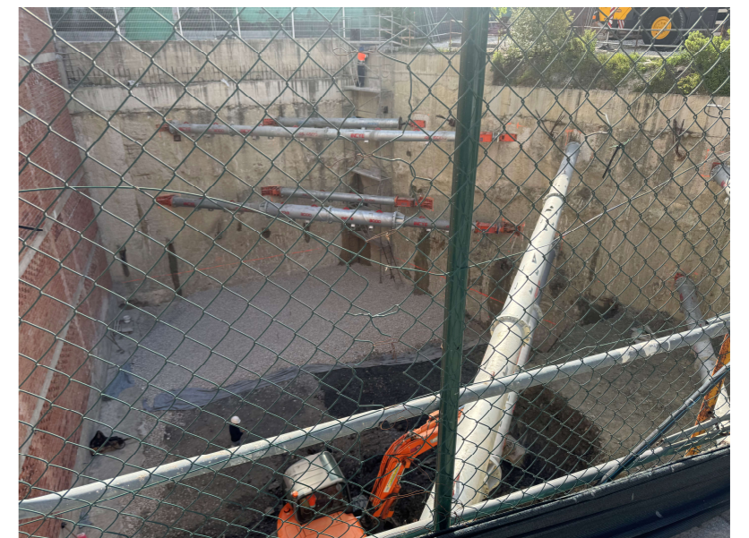
Fotografía 3. Vertido de grava para mejora del terreno
