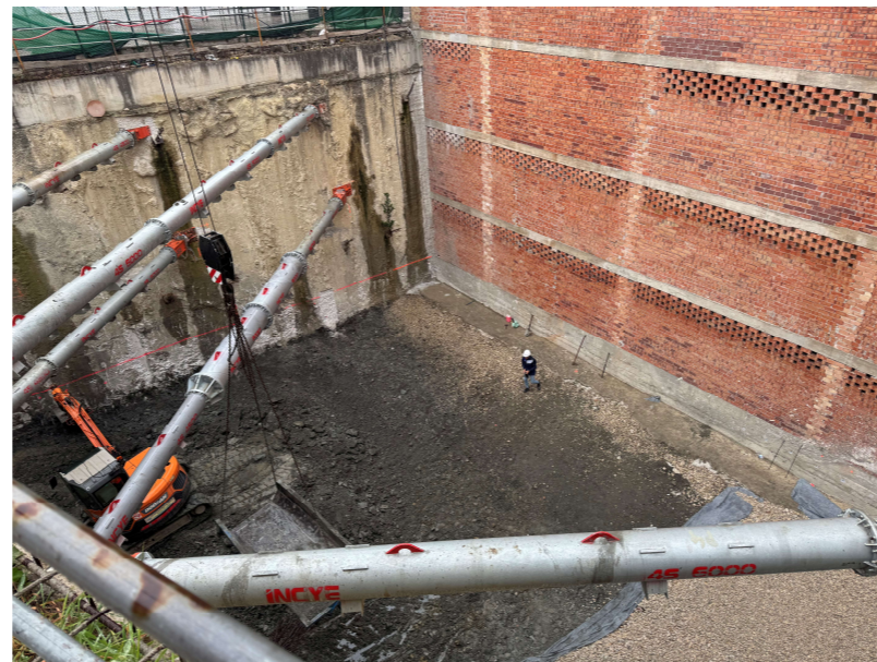
Fotografía 2. Excavación a punto de concluirse
