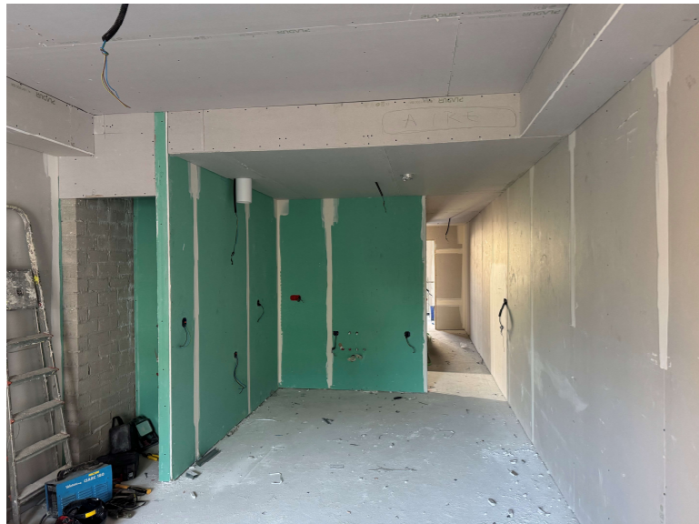
Fotografía 1. Tabiquería interior concluida
