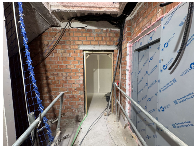
Fotografía 5. Instalación de ascensor.
