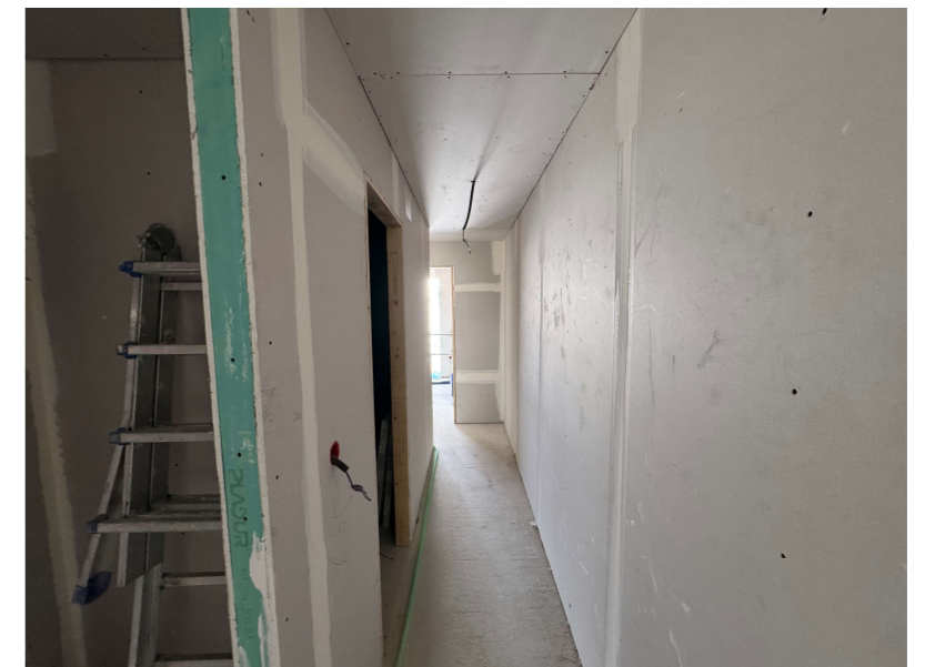
Fotografía 3. Ejecución paredes y techos
