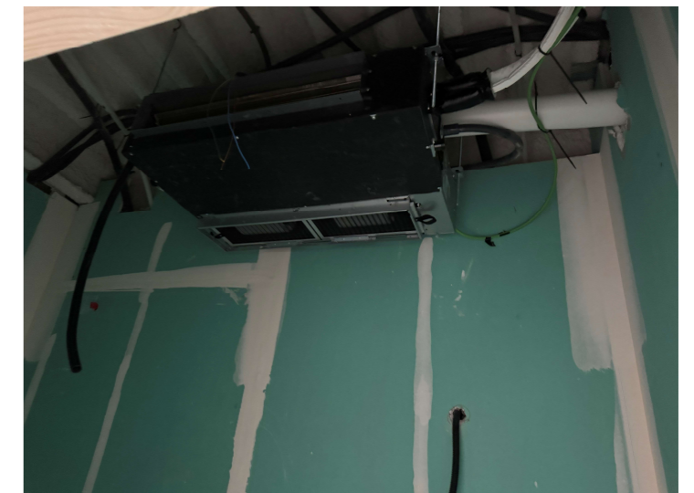
Fotografía 6. Instalación de máquinas interiores de Aire acond.
