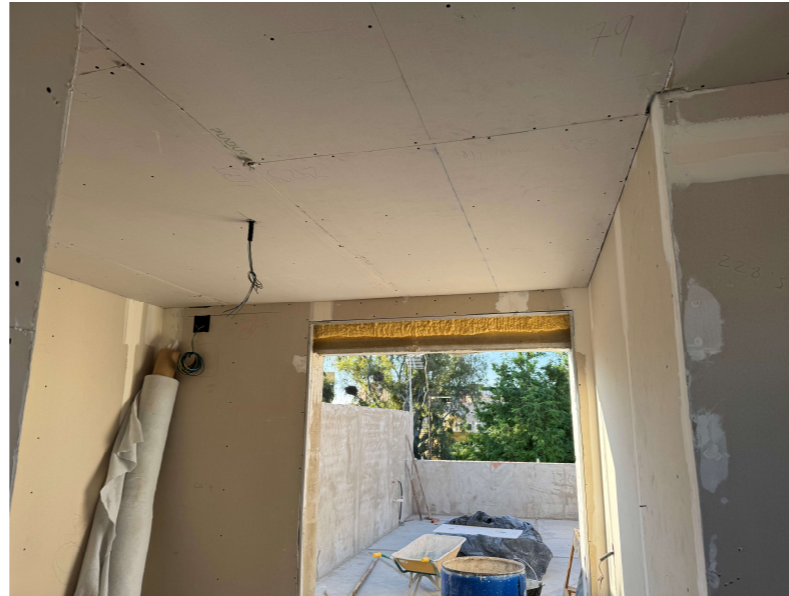
Fotografía 2. Falsos techos de yeso laminado iniciados
