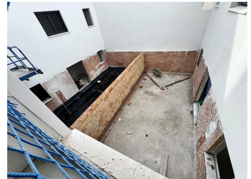
Fotografía 6. Partición de patio E2 y patio con prueba de estanqueidad.
