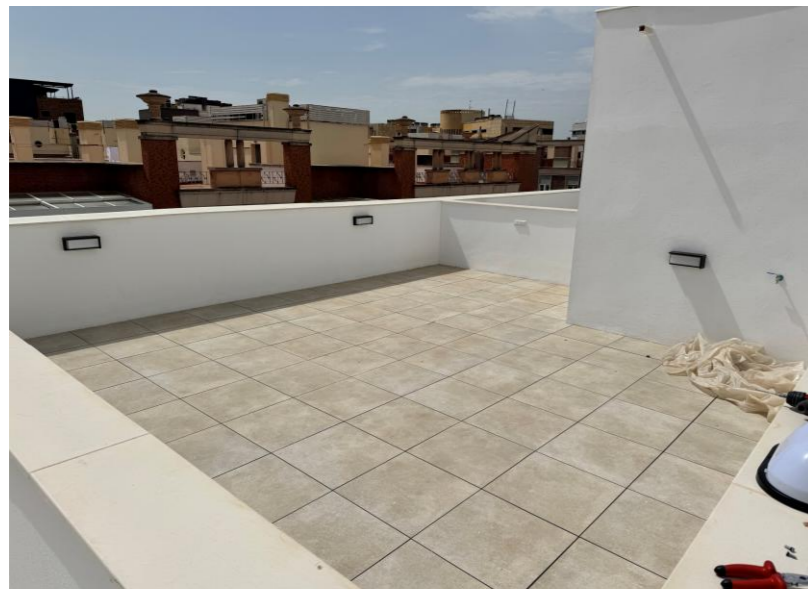
Fotografía 4. Azotea privativa con luminarias y suelo colocados
