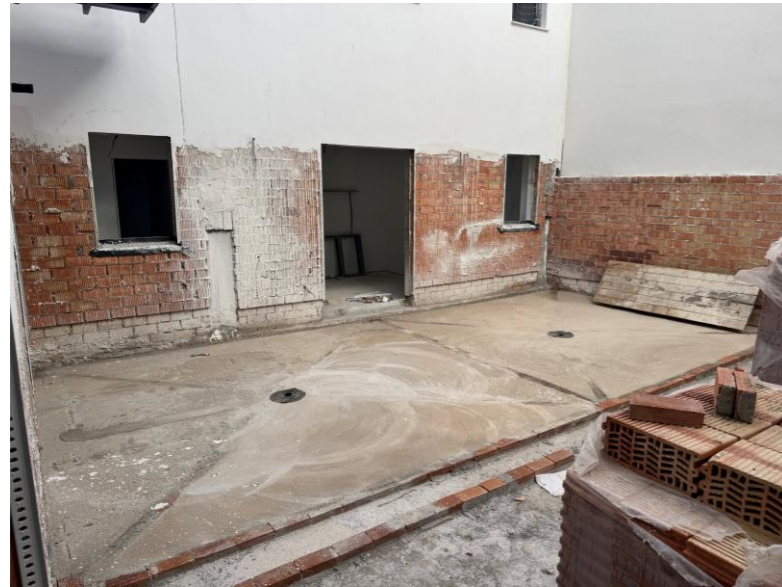
Fotografía 1. Formación de pendientes en patios interiores E3
