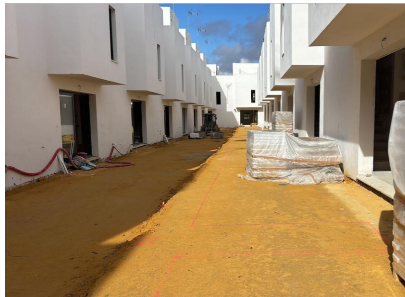
Fotografía 1. Consolidación del terreno para urbanización
