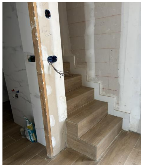
Fotografía 4. Vista revestimiento escalera con gres
