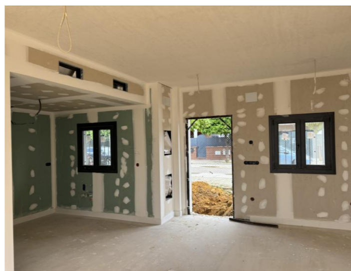
Fotografía 5. Avance encintados en casa c/ Tabarca
