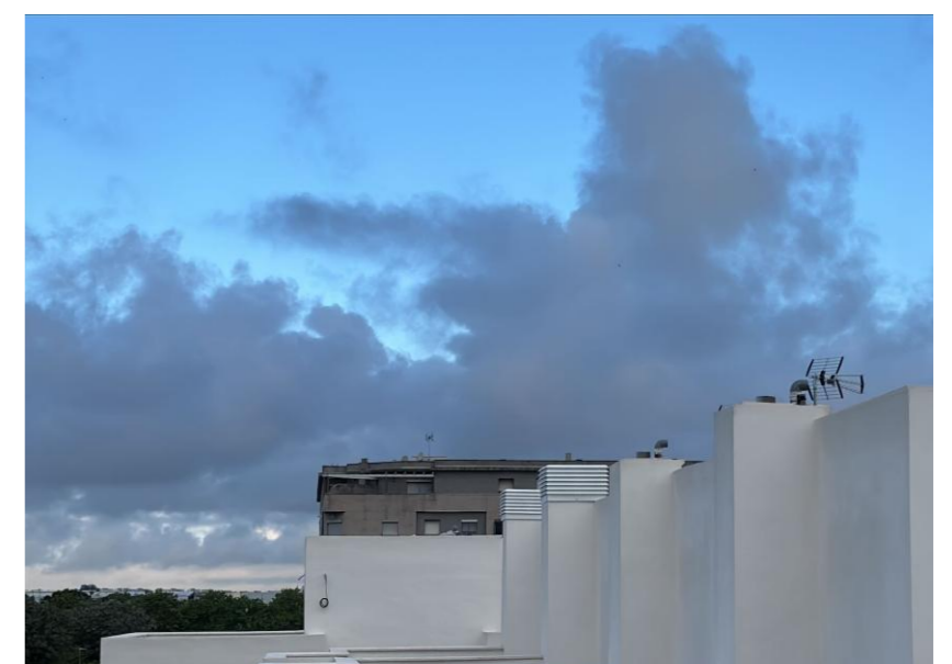
Fotografía 3. Colocación aspiradores estáticos en cubiertas
