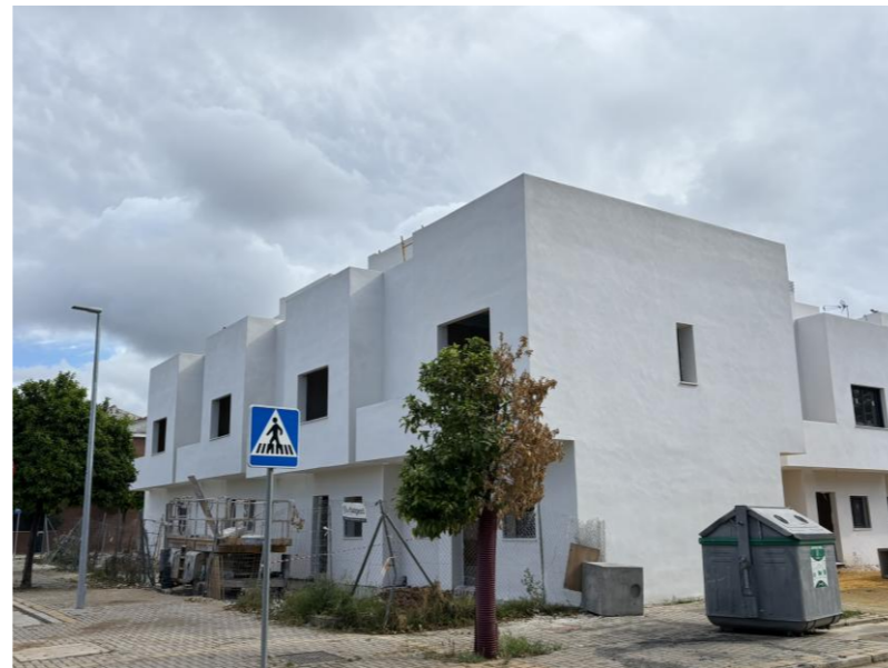
Fotografía 2. Finalización de mortero en último módulo
