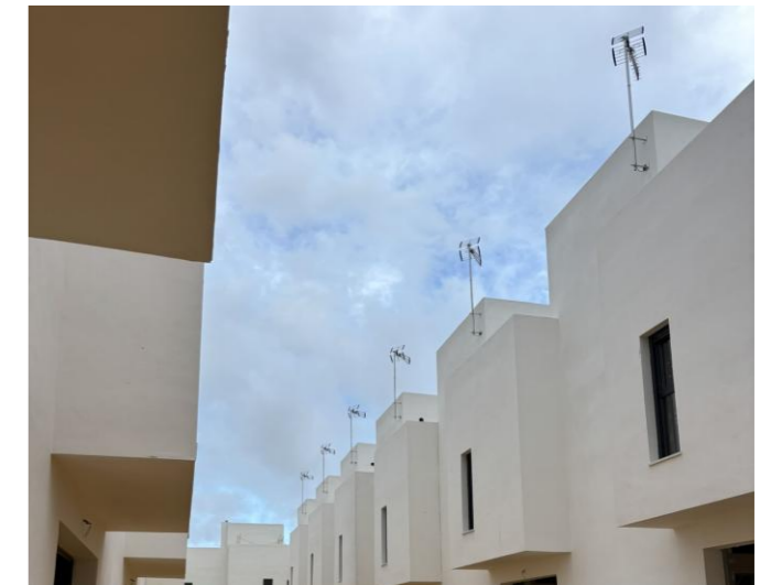
Fotografía 6. Avance de instalaciones de telecomunicaciones
