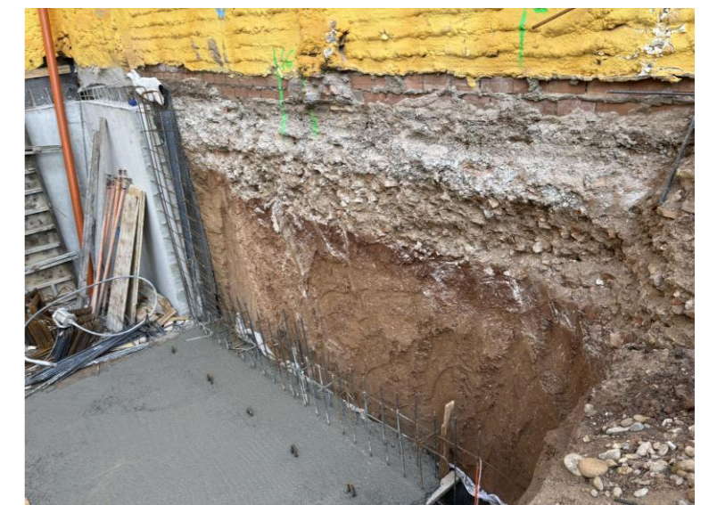
Fotografía 6. Hormigonado losa 7º batache
