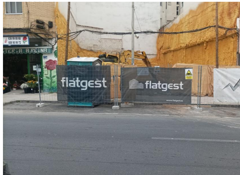
Fotografía 1. Vista cajón de obra.
