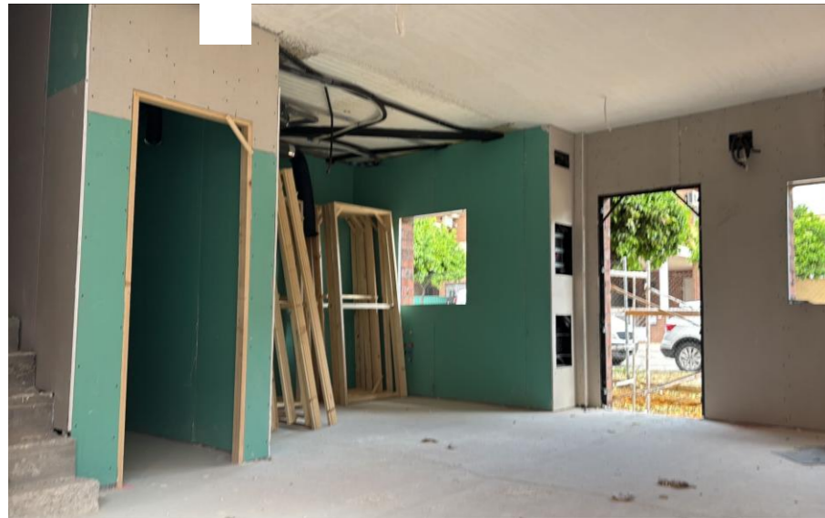
Fotografía 1. Cierre placas trasdosado en planta baja c/ Tabarca
