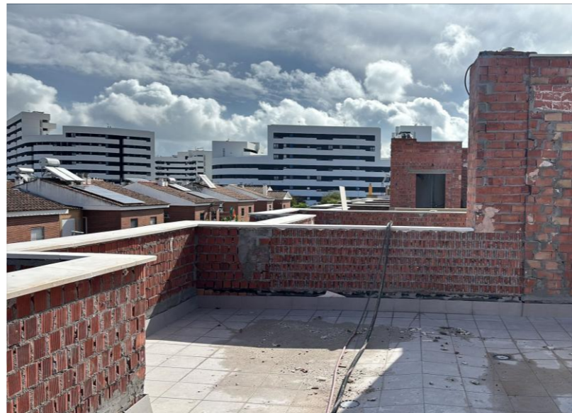
Fotografía 5. Avance colocación albardillas remate
