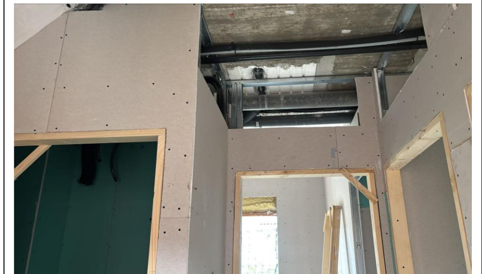
Fotografía 6: Cerrando 2º cara cartón yeso c/ Tabarca 1º planta
