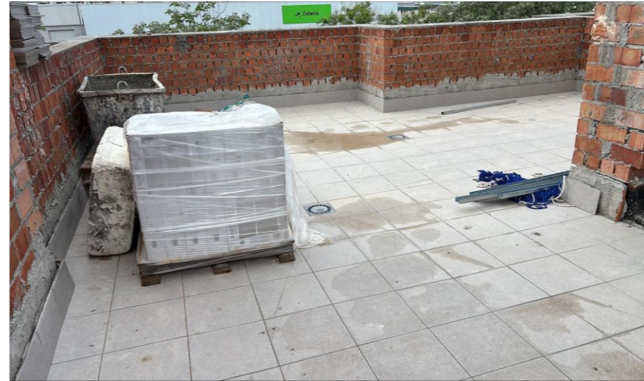
Fotografía 2. Finalizando terrazas viviendas c/ Las Melias
