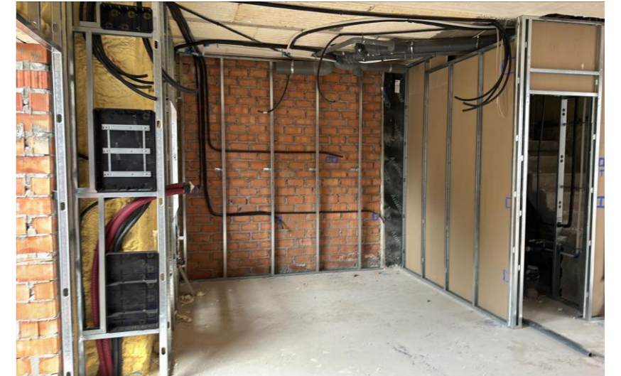
Fotografía 3. Colocación estructuras cartón yeso en c/ Las Melias
