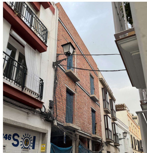
Fotografía 1. Estado Fachada principal
