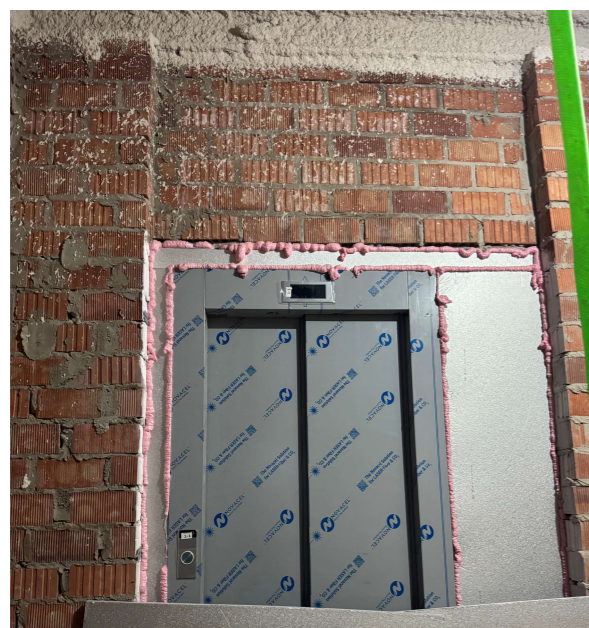
Fotografía 4. Ascensor instalado
