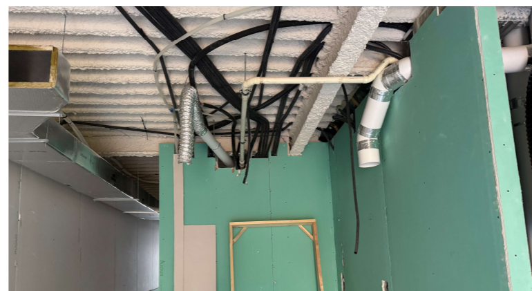
Fotografía 5. Ejecución de las distintas instalaciones
