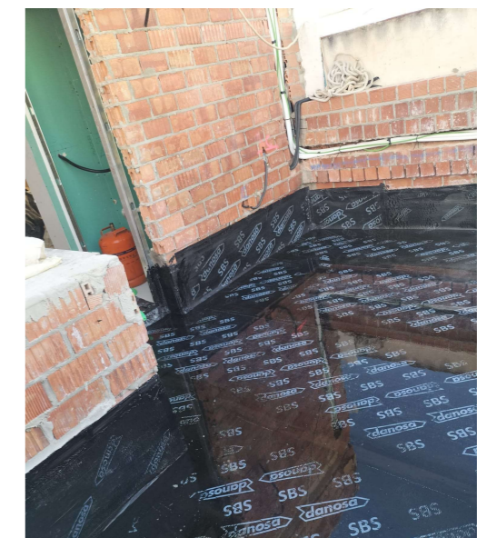
Fotografía 6. Impermeabilización de cubiertas
