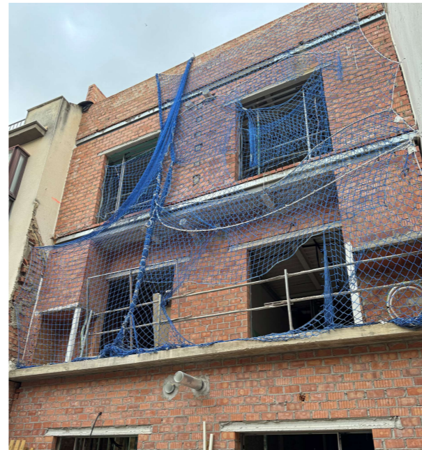
Fotografía 2. Estado Fachada posterior
