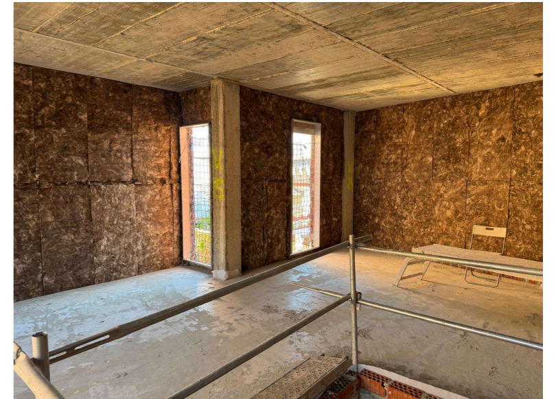
Fotografía 3. Cerramiento de fachada con aislamiento adherido
