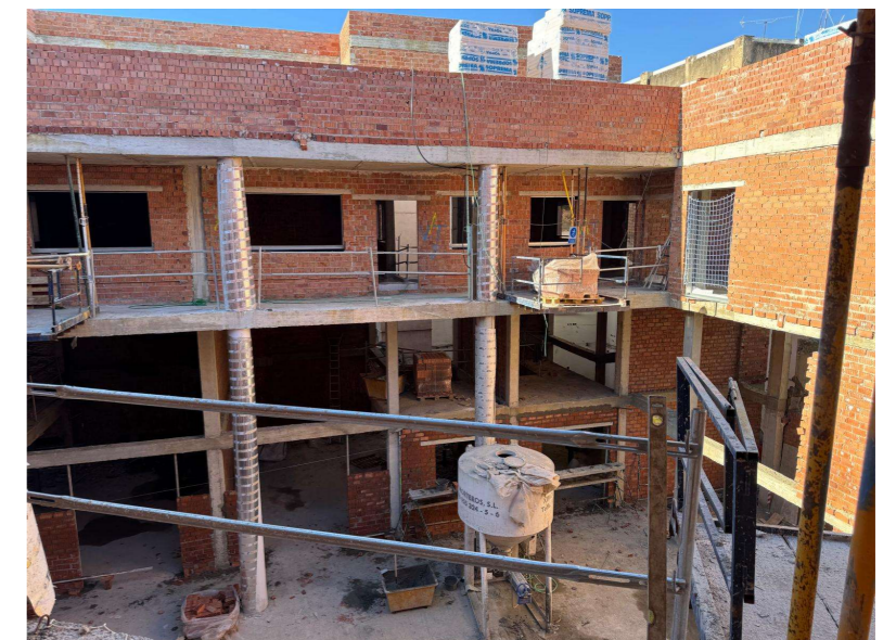
Fotografía 6. Trabajos de cerramientos de fábrica de ladrillo
