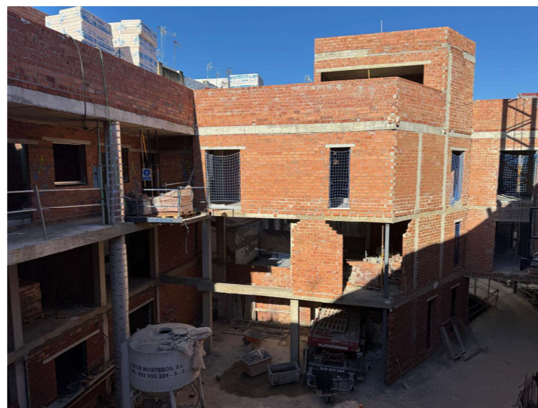
Fotografía 5. Trabajos de cerramientos de fábrica de ladrillo
