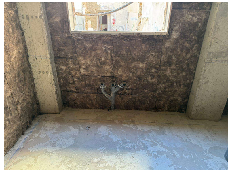
Fotografía 4. Cerramiento con aislamiento e instalaciones
