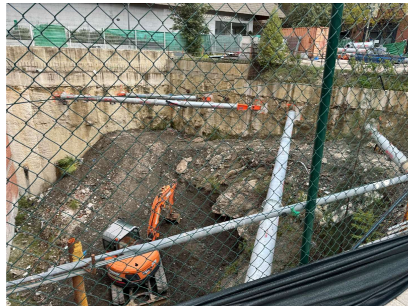
Fotografía 2. Acodamiento de Pantallas
