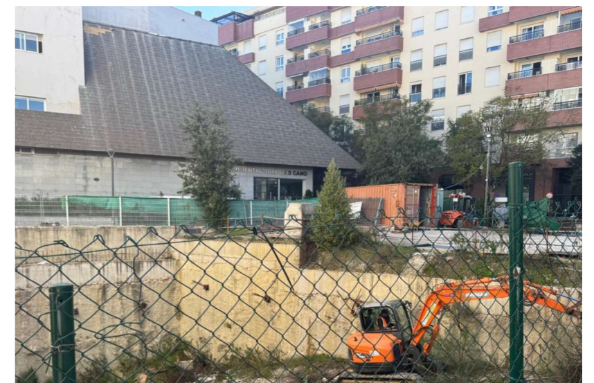
Fotografía 6. Estado previo de Plaza colindante. Casetas Obra.
