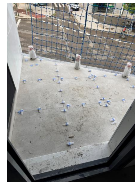
Fotografía 6. Solado de terraza Avda. Gran Capitán
