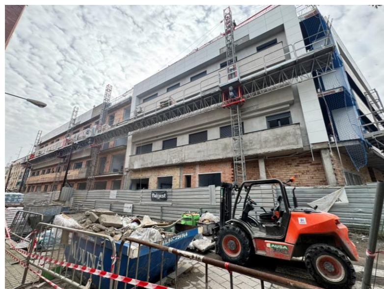
Fotografía 1. Avance de fachada c/ Abderraman III
