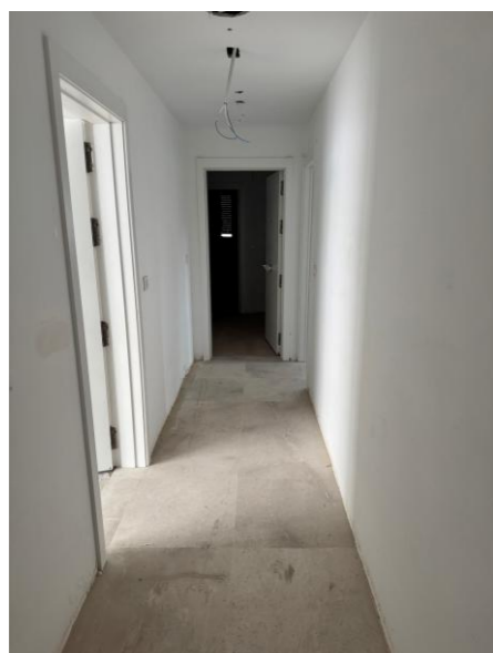
Fotografía 4. Pasillo E1 plantas superiores.
