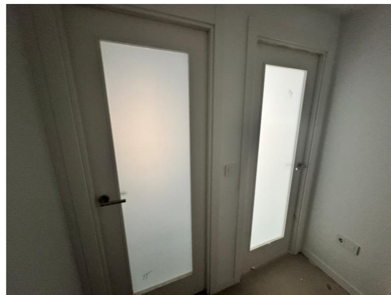
Fotografía 2. Vista puertas con vidrio
