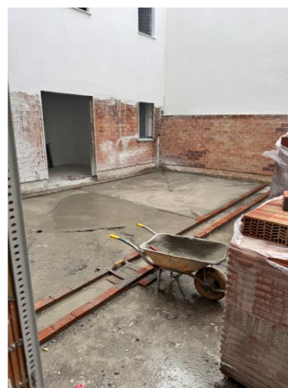
Fotografía 5. Formación de pendientes de patios interiores en E1.
