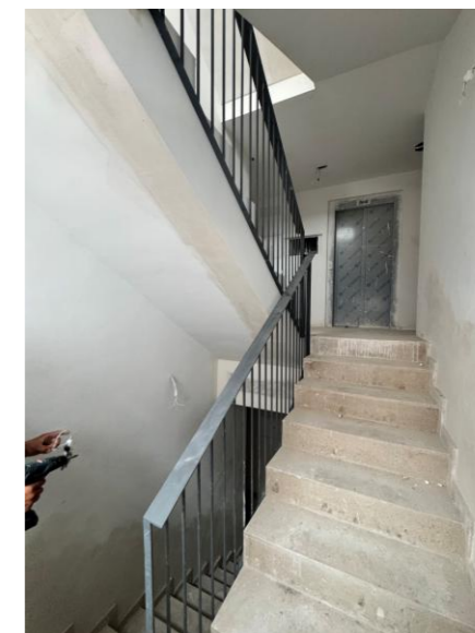
Fotografía 3. Perspectiva de Barandilla en E1.
