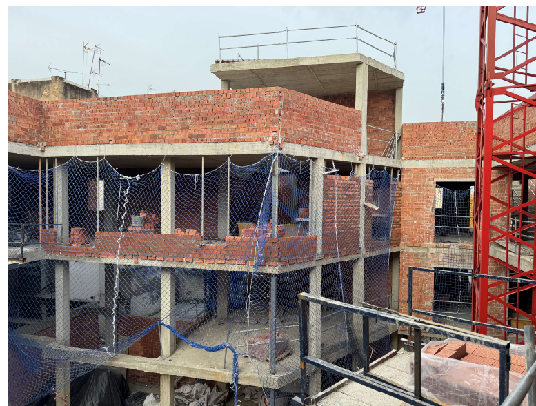
Fotografía 5. Trabajos de cerramientos de fábrica de ladrillo
