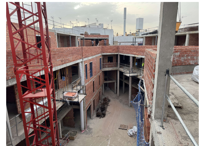
Fotografía 6. Trabajos de cerramientos de fábrica de ladrillo
