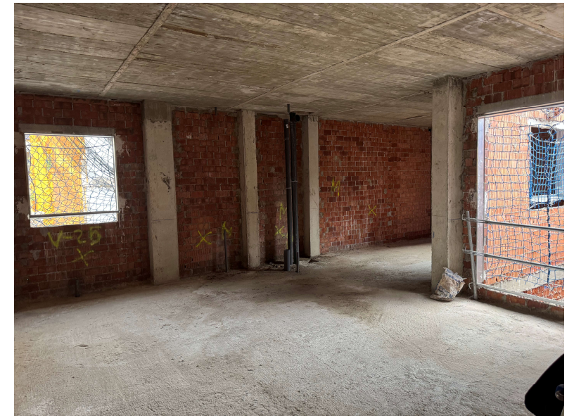
Fotografía 3. Preparación de huecos de fachada
