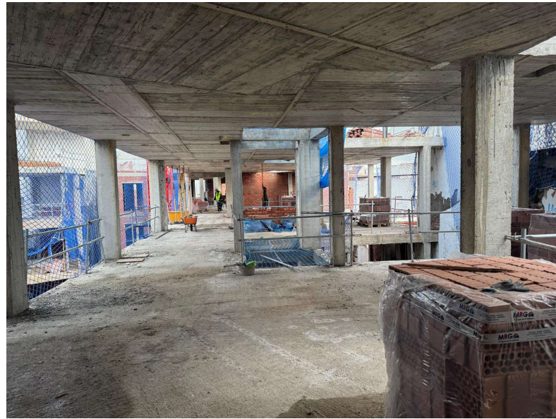
Fotografía 2. Trabajos generales de estructura
