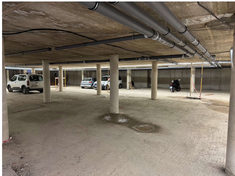
Fotografía 1. Planta sótano con inicio de instalaciones
