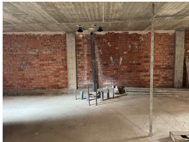
Fotografía 4. Inicio de instalaciones en viviendas
