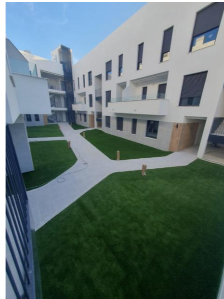
Fotografía 2. Vista panorámica patio terminado con césped.
