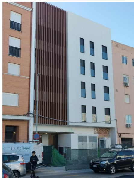
Fotografía 4. Fachada principal finalizada.
