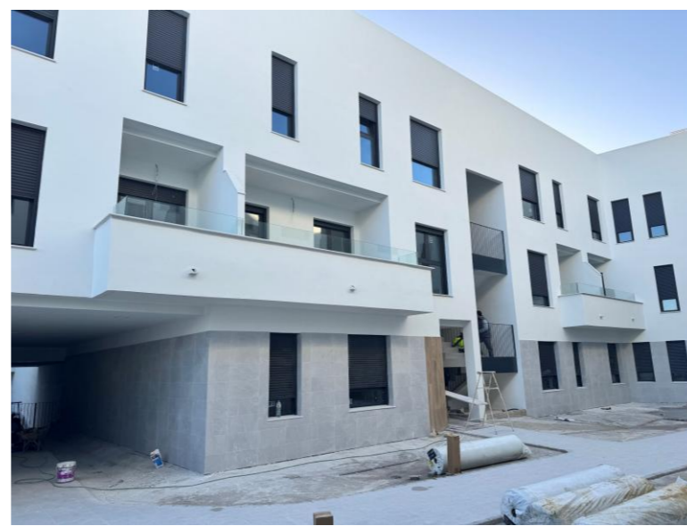
Fotografía 5. Portales C, F y G terminado a falta del césped.
