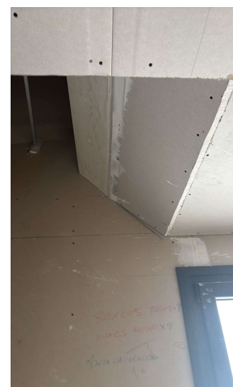
Fotografía 5. Terminación de falso techo en planta primera
