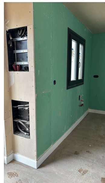
Fotografía 2. Colocación de rodapiés.
