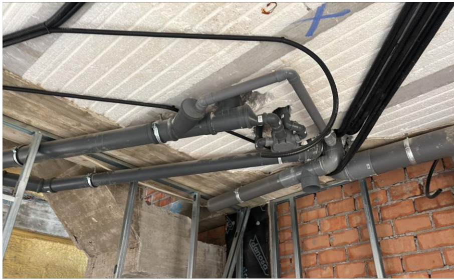
Fotografía 6: Finalización red de saneamiento y ventilación.
