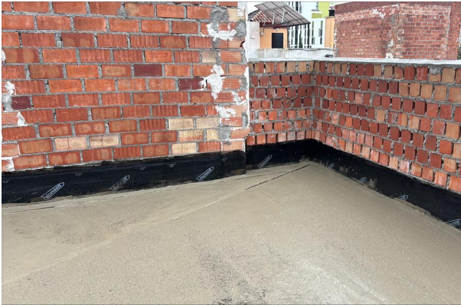
Fotografía 4. Ejecución pendientes en cubierta, viviendas c/ Tabarca
