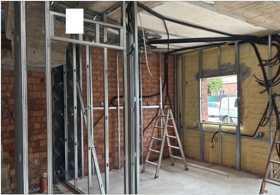
Fotografía 1. Colocación estructura cartón-yeso en planta baja
