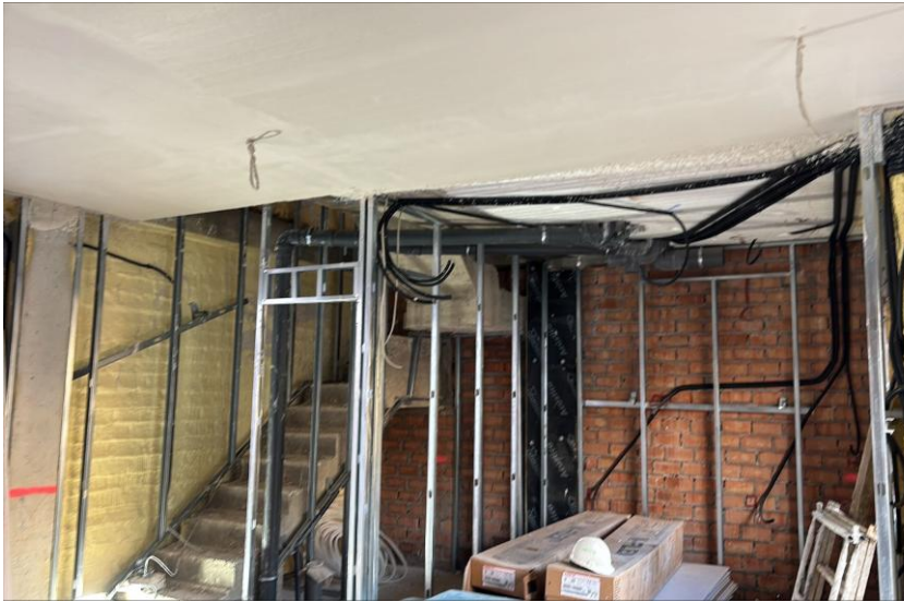
Fotografía 3. Enlucido de yeso en techos planta baja
