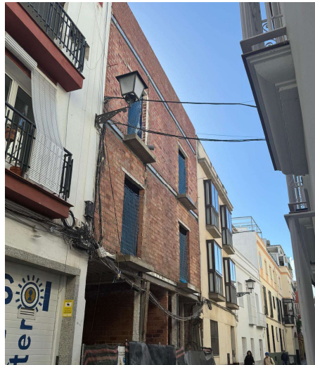
Fotografía 1. Cerramiento de fachada delantera
