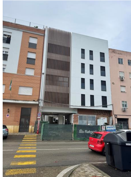
Fotografía 2. Vista fachada principal más avanzada.
