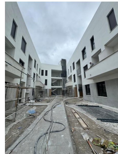
Fotografía 6. Vista de pasillo interior terminando acabados
