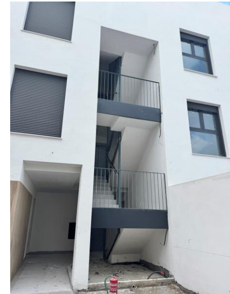
Fotografía 3. Vista de barandillas de escalera portal D.
