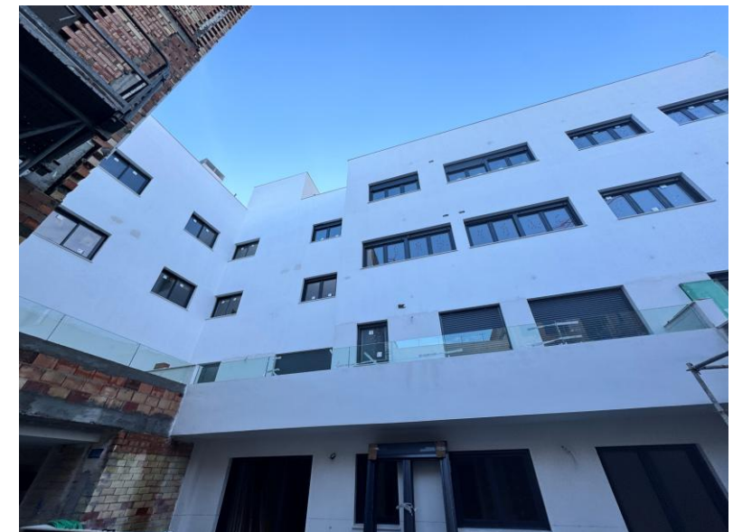
Fotografía 6. Alzado interior de escalera 4 con barandilla.
