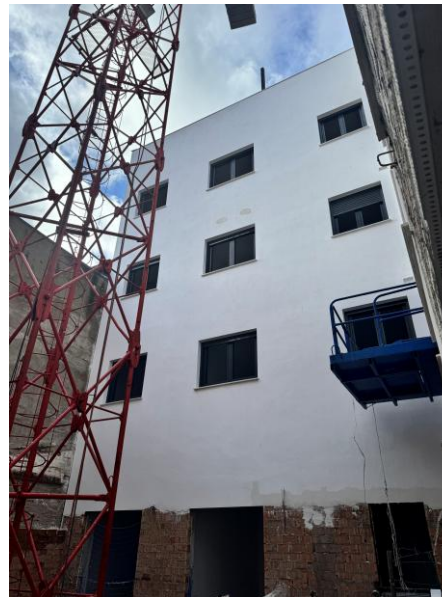
Fotografía 2. Patio interior bloque 1 con carpintería de aluminio
