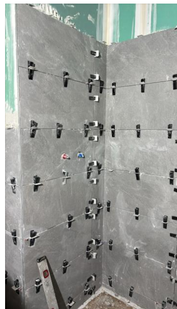
Fotografía 2. Avance en colocación de alicatados.
