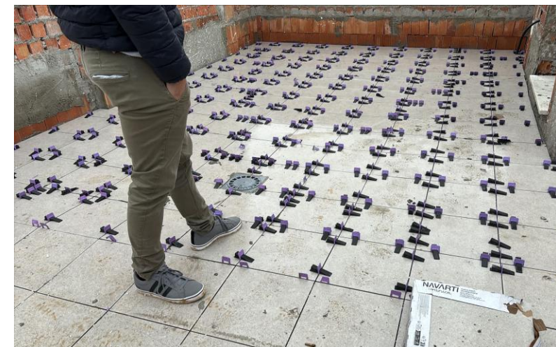
Fotografía 6. Avance de solado de terraza viviendas c/ Tabarca
