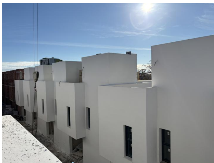
Fotografía 5. Vista avance de enfoscados exteriores
