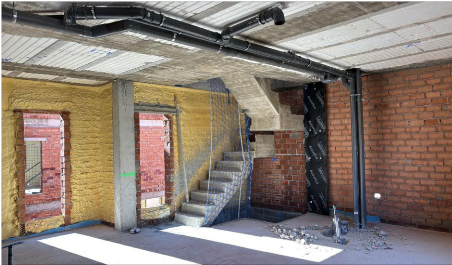
Fotografía 2. Avance red de saneamiento viviendas c/ Tabarca
