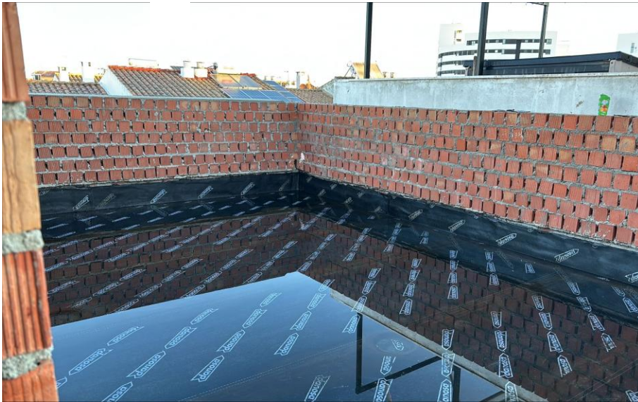
Fotografía 1. Prueba estanqueidad terrazas viviendas c/ Tabarca
