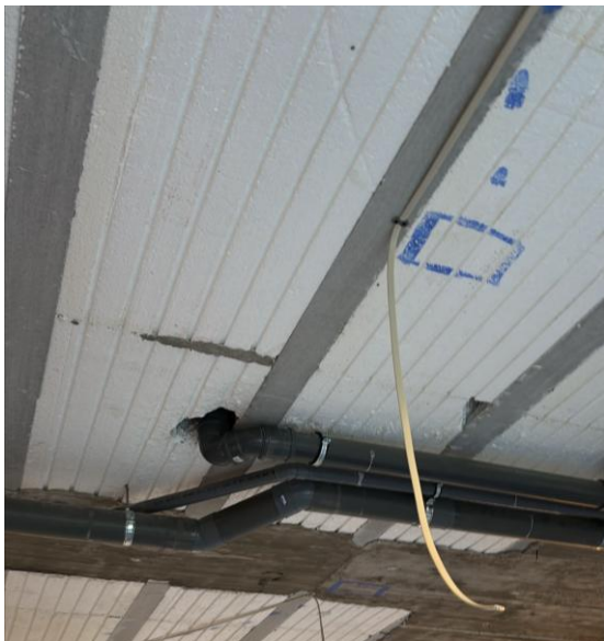
Fotografía 5. Colocación de cableado para puntos de luz
