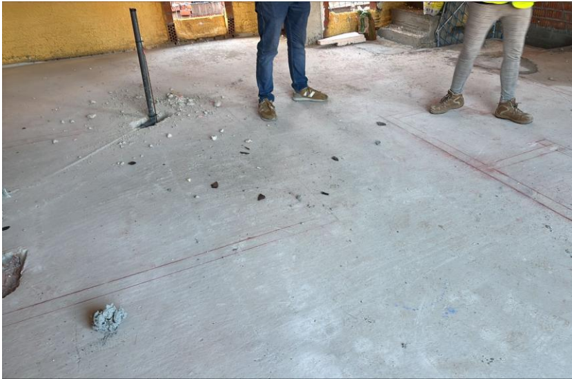
Fotografía 3. Comprobación replanteo de los tabiques viviendas.
