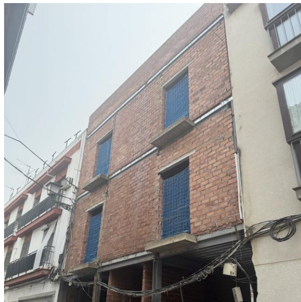
Fotografía 1. Cerramiento de fachada delantera
