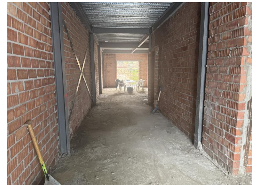
Fotografía 3. Cerramiento median exteriores y zonas comunes
