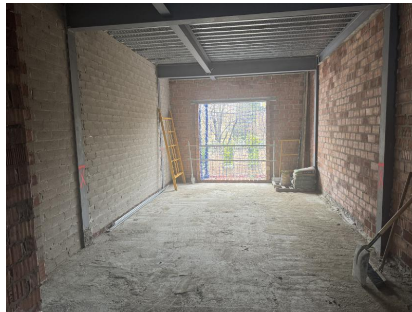
Fotografía 2. Medianeras ladrillo fónico y fachada trasera
