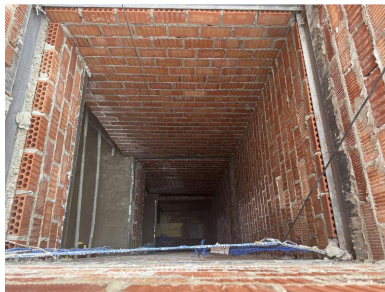
Fotografía 4. Hueco ascensor con fábrica de ladrillo LMP
