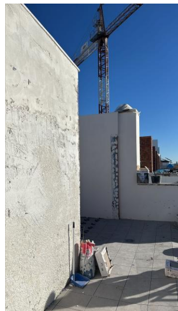
Fotografía 2. Vista fachadas castilletes y solerías
