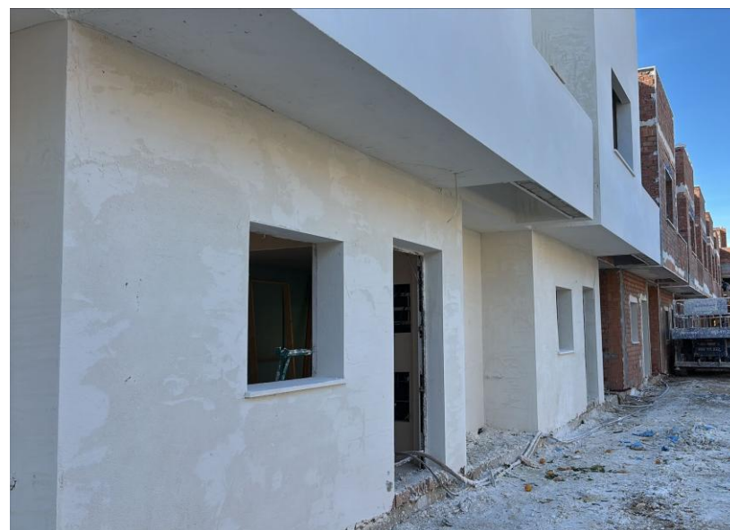
Fotografía 1. Avance enfoscado en viviendas c/ Tabarca
