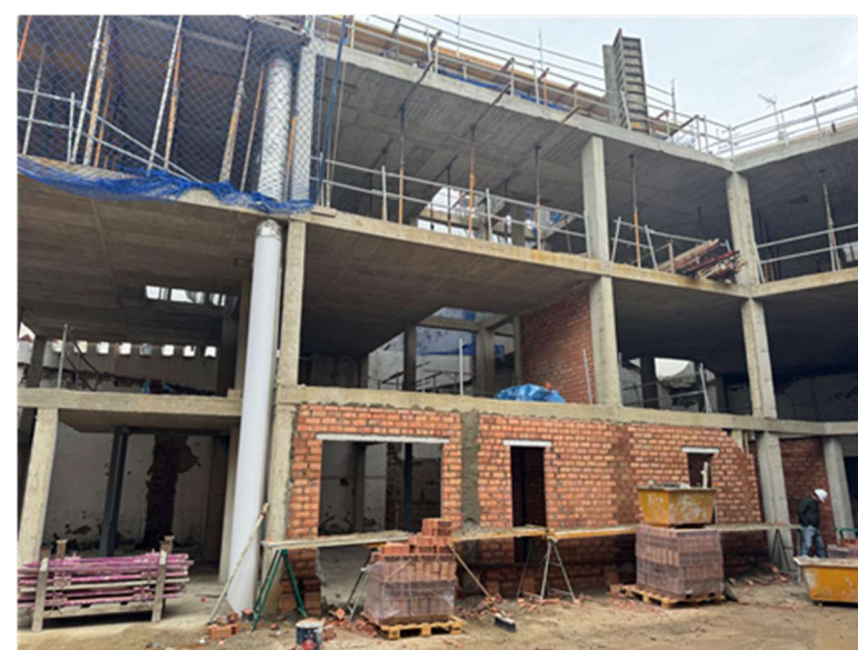
Fotografía 5. Inicio trabajos de albañilería
