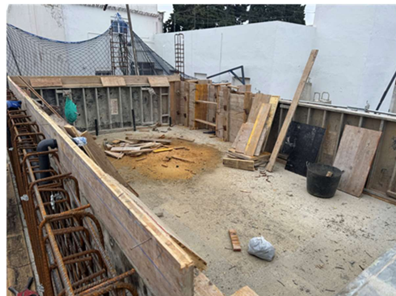
Fotografía 4. Ejecución vaso de piscina
