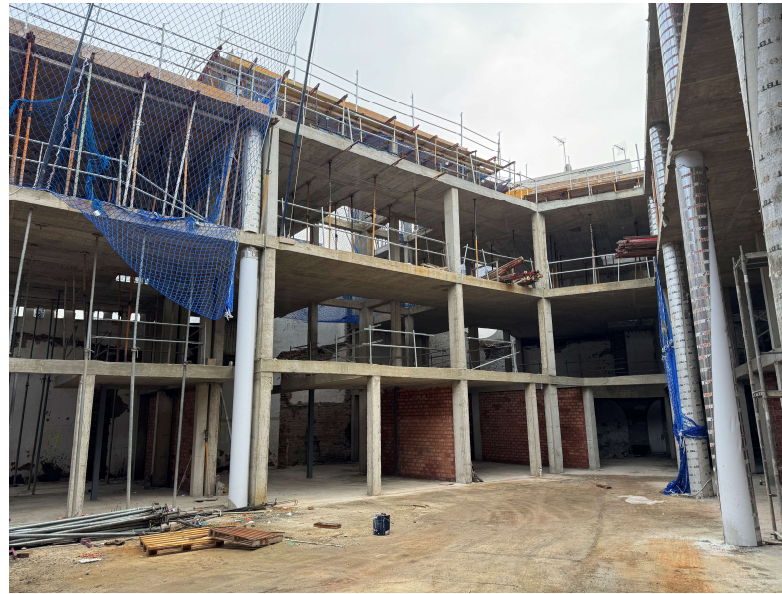
Fotografía 2. Trabajos generales de estructura
