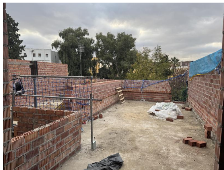
Fotografía 4. Pretil de cubierta
