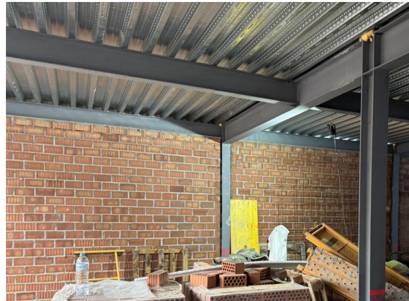
Fotografía 2. Cerramiento de las medianeras
