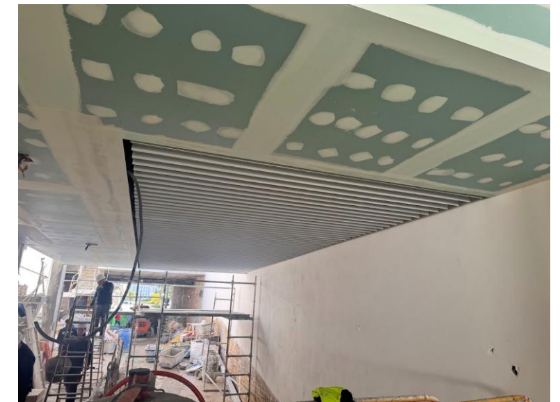
Fotografía 3. Techo comunitario zona rampa bajo bloque B
