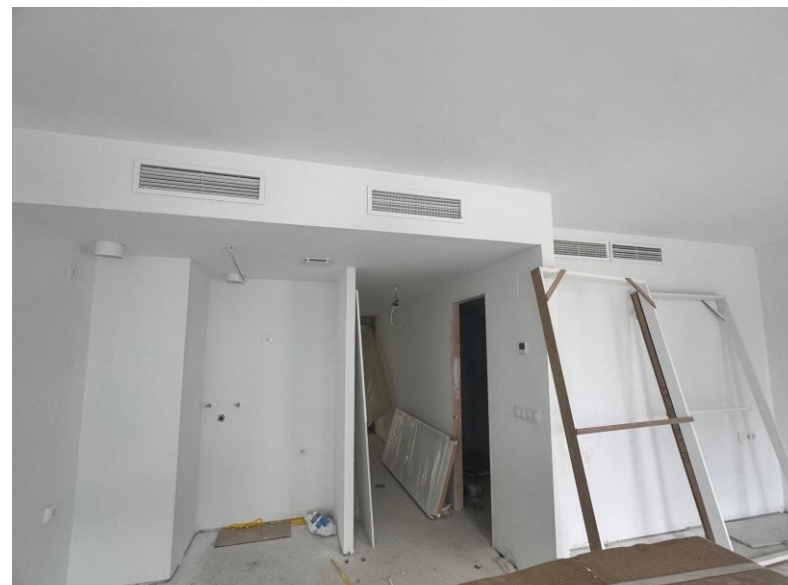
Fotografía 5. Vista interior vivienda bloque A
