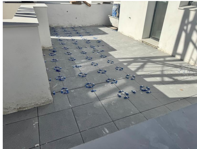
Fotografía 2. Colocación de solería en cubiertas privadas
