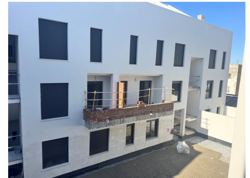
Fotografía 6. Vista de Alzados bloques D y E con balcones
