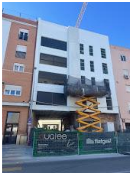
Fotografía 1. Vista de alzado principal calle
