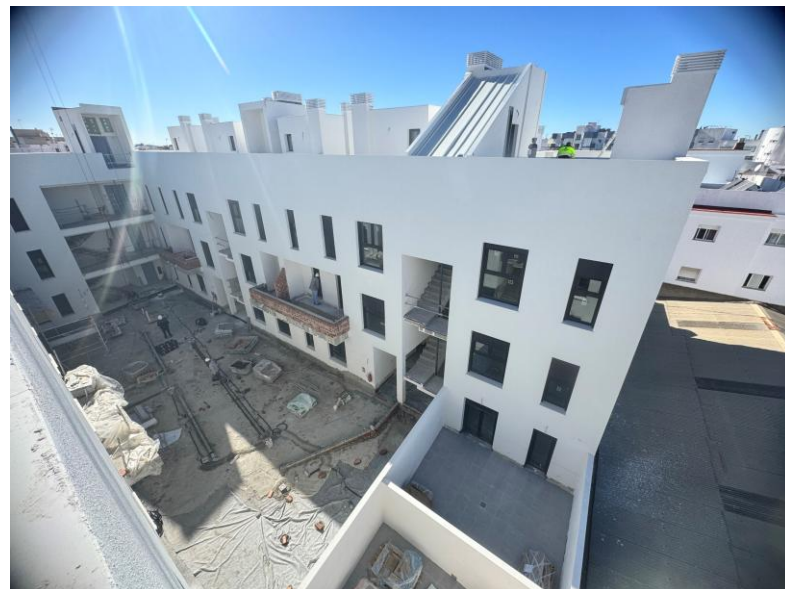
Fotografía 4. Vista aérea patio central y bloques C al F
