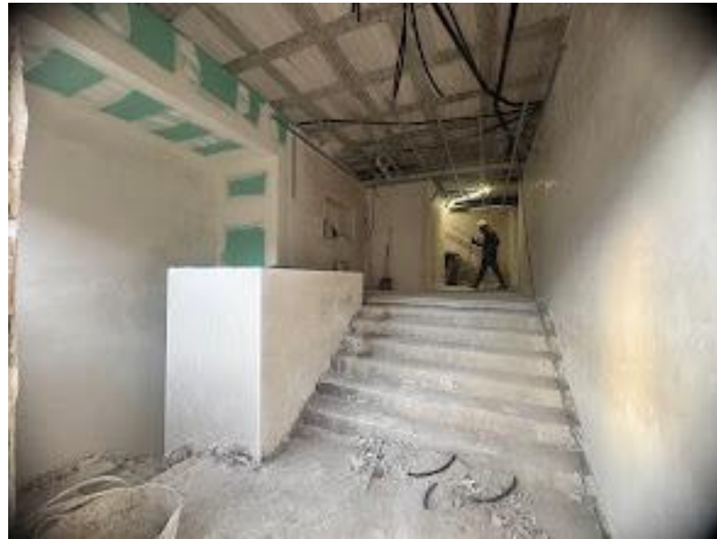
Fotografía 1. Acceso calle en Escalera 4 (bloque 2)
