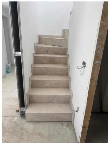
Fotografía 4. Escaleras privadas soladas
