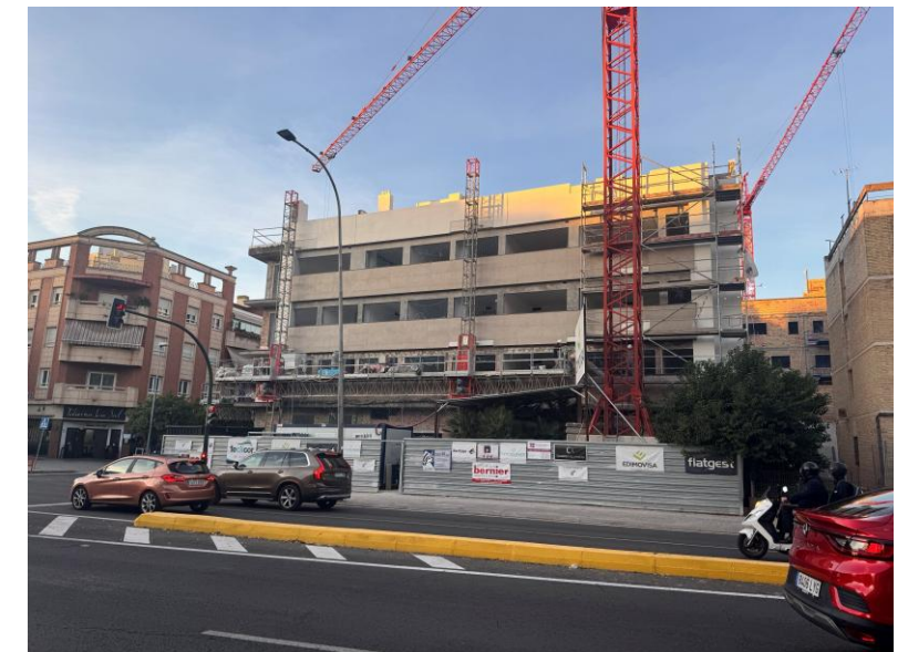
Fotografía 6. Ejecución de acabados en fachada Avda. Brillante
