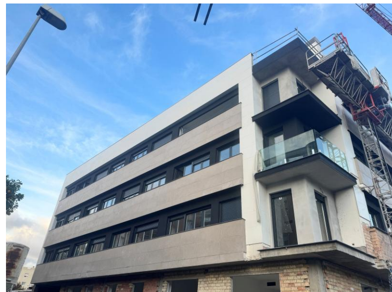
Fotografía 5. Fachada c/ Doña Berenguela sin andamios
