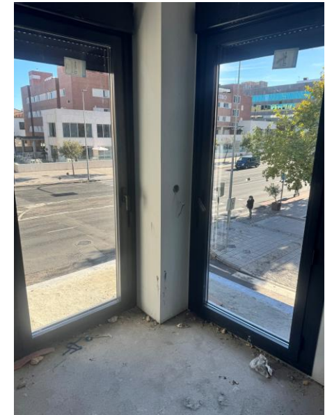
Fotografía 3. Colocación de balconeras
