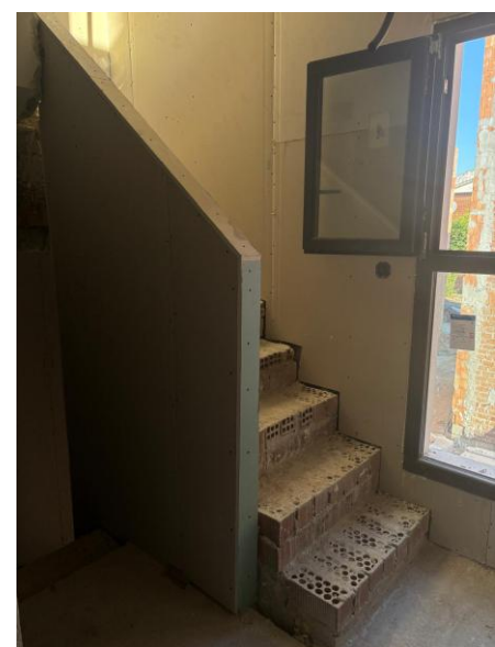
Fotografía 5. Escalera a ático
