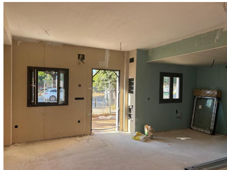
Fotografía 4. Interior planta baja
