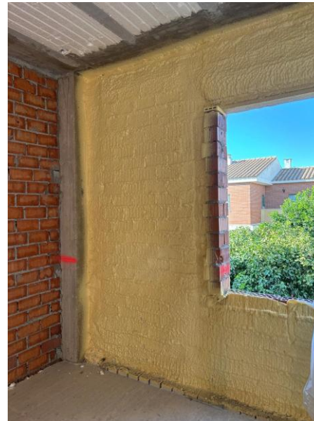
Fotografía 2. Vista cerramiento con aislamiento interior.
