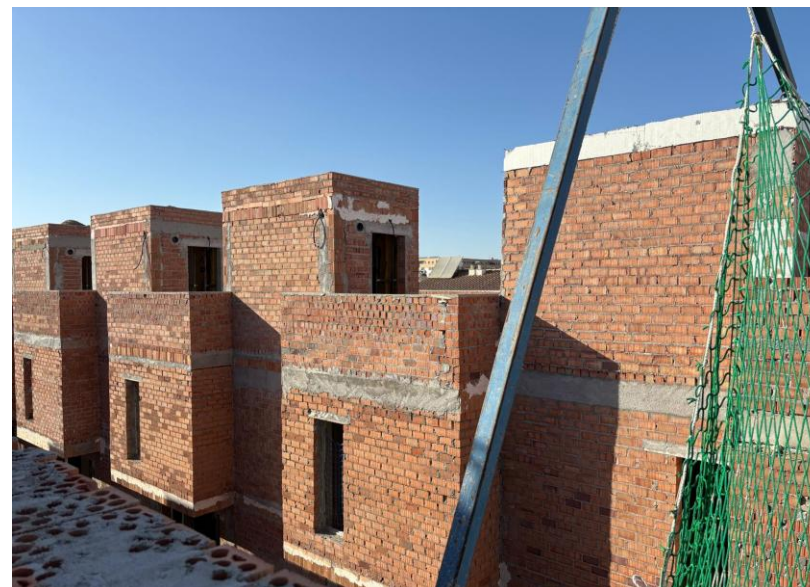
Fotografía 5. Vista fachada posterior.
