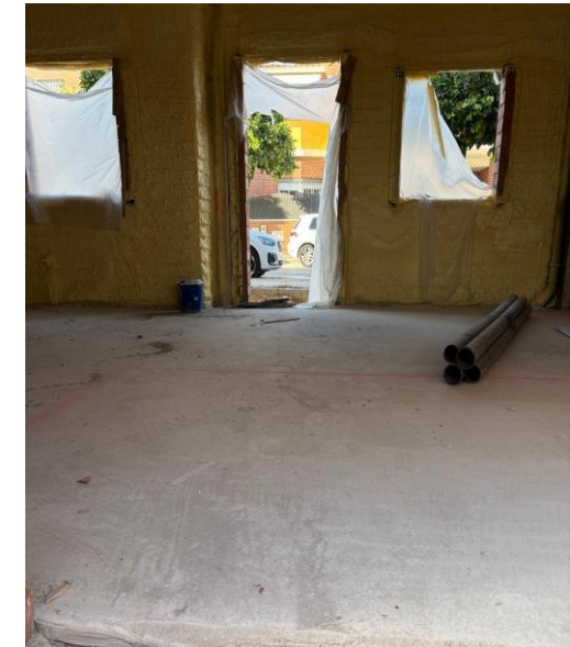
Fotografía 3. Vista de vivienda con autonivelante
