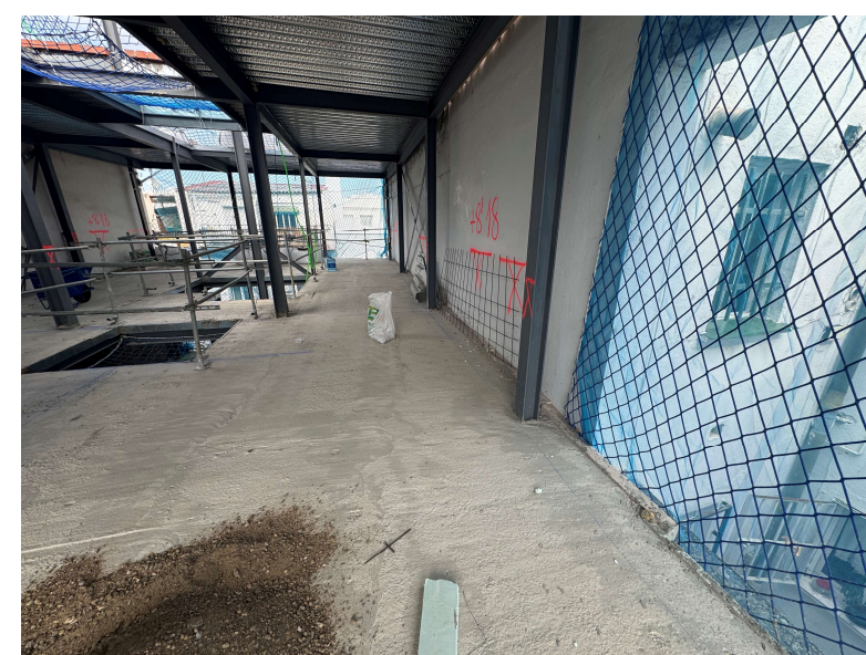
Fotografía 5. Estructura planta segunda
