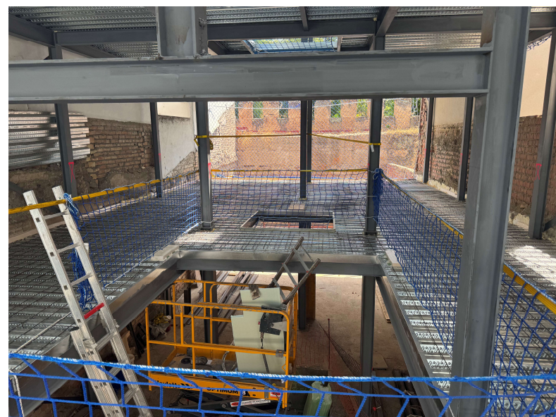
Fotografía 4. Ejecución estructura planta primera
