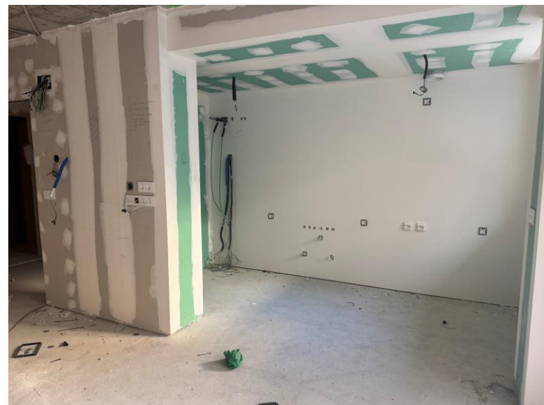
Fotografía 5. Vista de Salón-Cocina con frente de cocina alicatado
