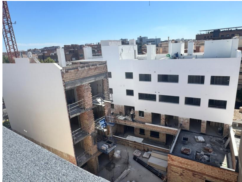
Fotografía 1. Fachada interior bloque 2 (E4)
