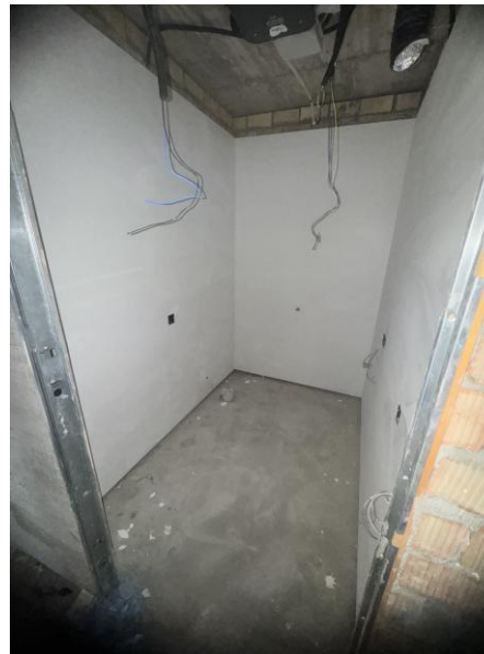
Fotografía 2. Aseo piscina alicatado
